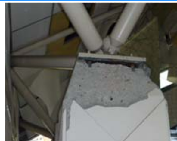
柱脚（支承部）コンクリート剥落
