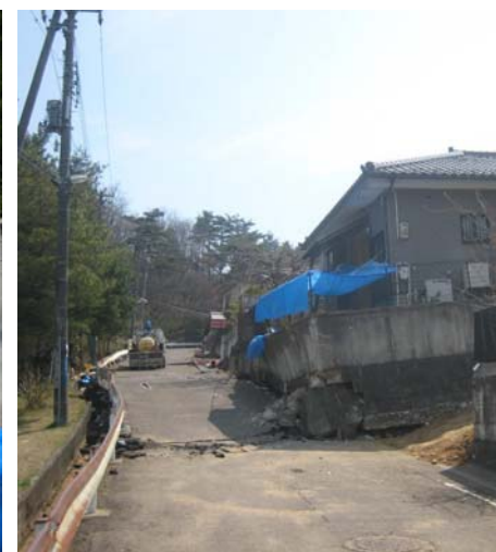
宅地地盤の大規模な崩落・滑り出し
