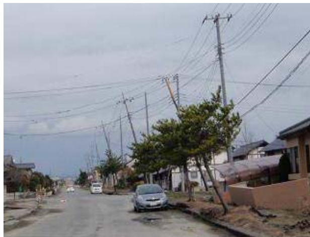
大規模な液状化と構造物の沈下・傾斜
