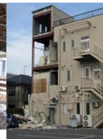
柱脚（支承部）コンクリート剥落
