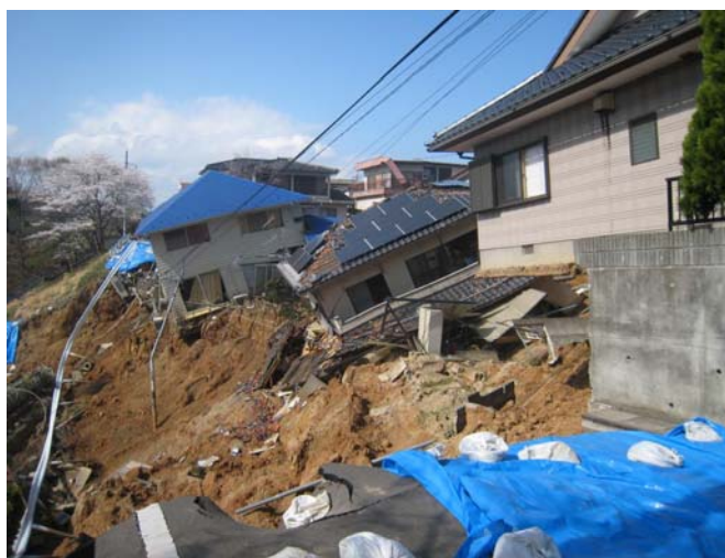
宅地地盤の大規模な崩落・滑り出し
