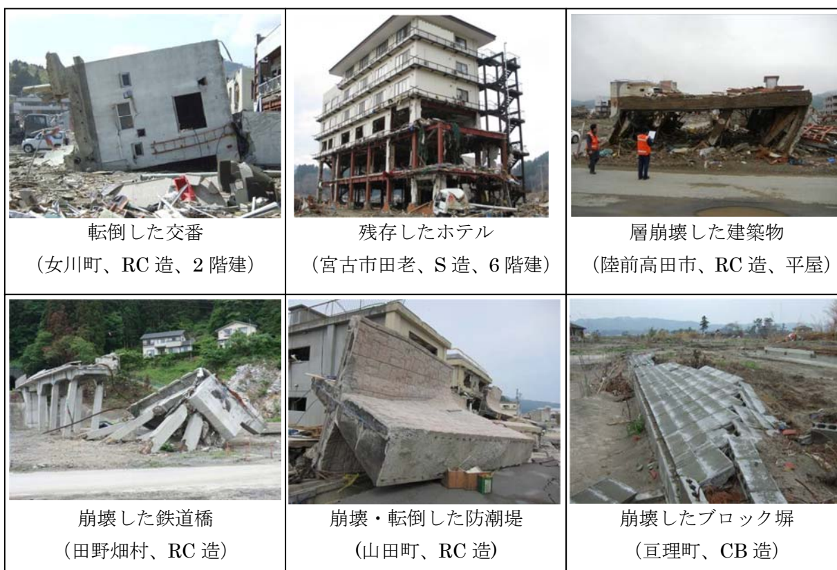
図 3.2 調査地域と被害状況写真例
