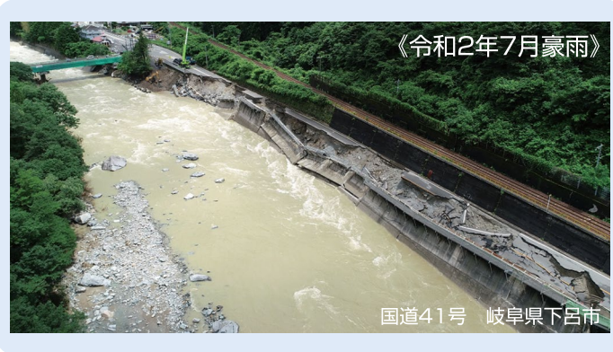
(道路構造物研究部)
