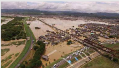
平成30年7月豪雨による堤防の決壊
