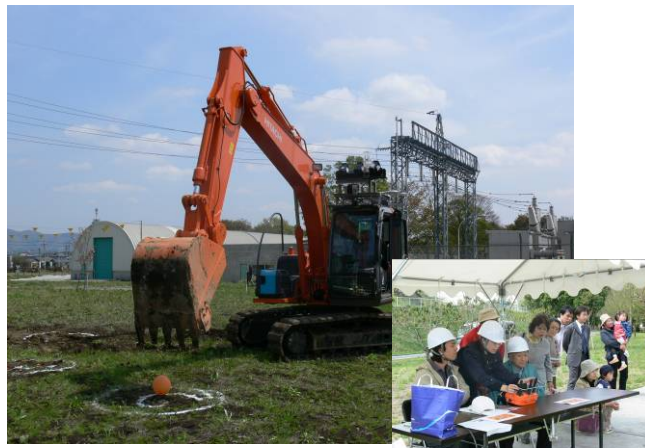
写真-2 ロボット建設機械
