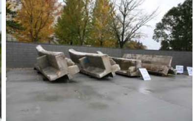
橋梁の撤去部材
