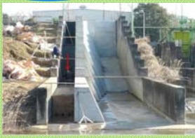
粘り強い海岸堤防の実験施設をご案内します (高落差実験水路)
