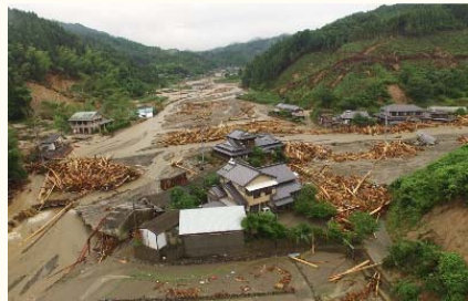
H29.7九州北部豪雨被災状況
