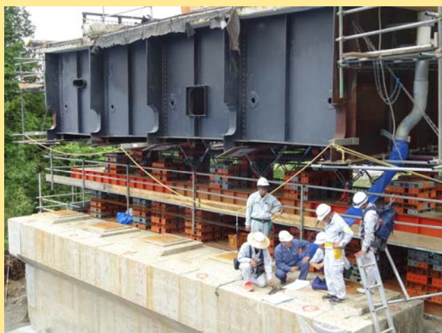
ジャッキアップされた4,000 tの鋼上部構造と その据え付け位置に関する現地技術指導
