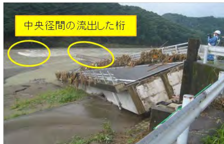
令和2年7月球磨川豪雨の被害 (熊本県道17号 沖鶴橋)
