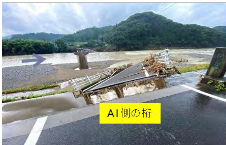
令和2年7月球磨川豪雨の被害 (熊本県道17号 沖鶴橋)
