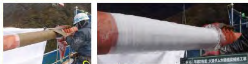
防食テープの施工
