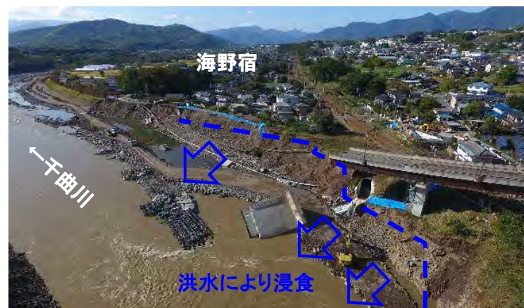
橋梁の流出状況
