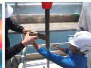
防食テープの施工
