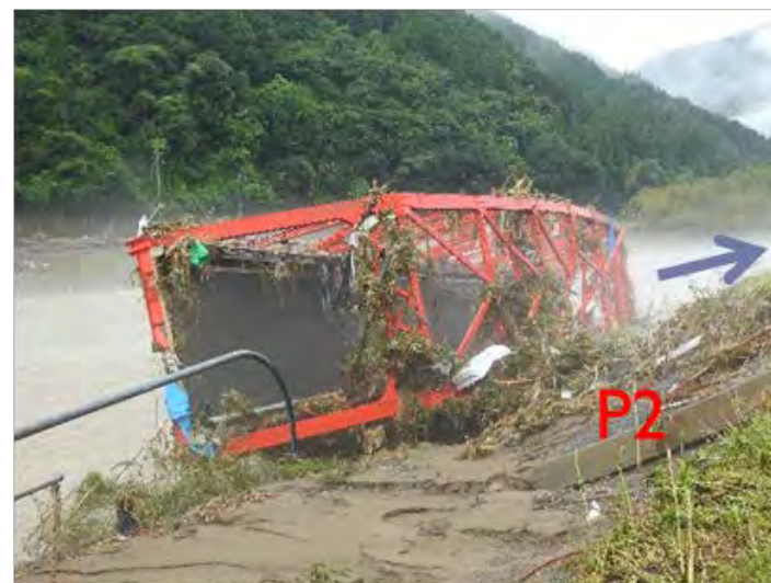
令和2年7月球磨川豪雨の被害 (熊本県道325号 相良橋)
