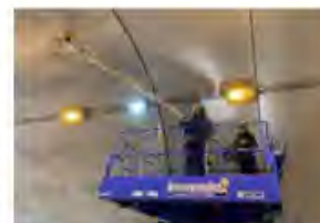
レーザーを利用したトンネル覆工の損傷把握
