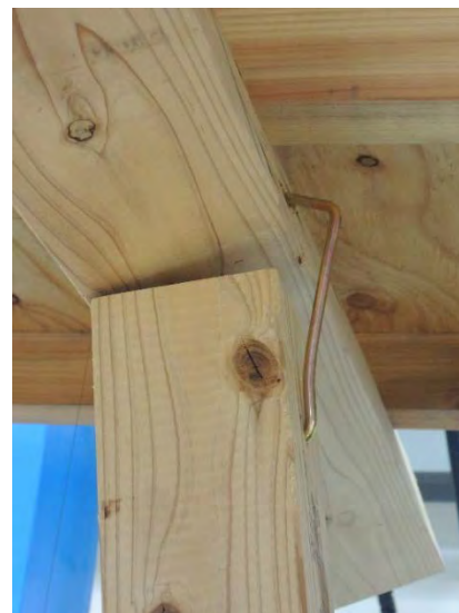
小屋東上端の かすがい接合部
