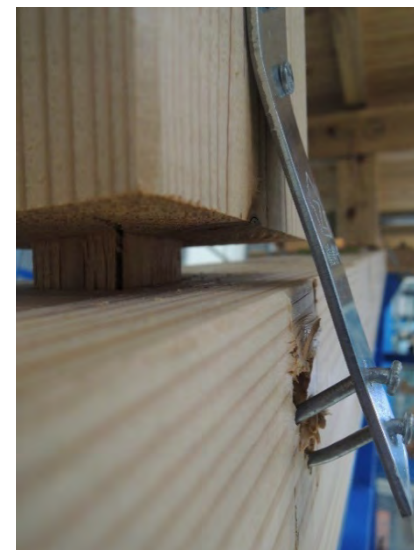
小屋東下端の ひら金物接合部
