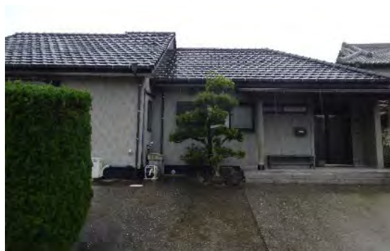
無被害の ガイドライン工法 による瓦屋根
