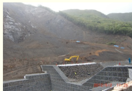
対策工事実施状況
