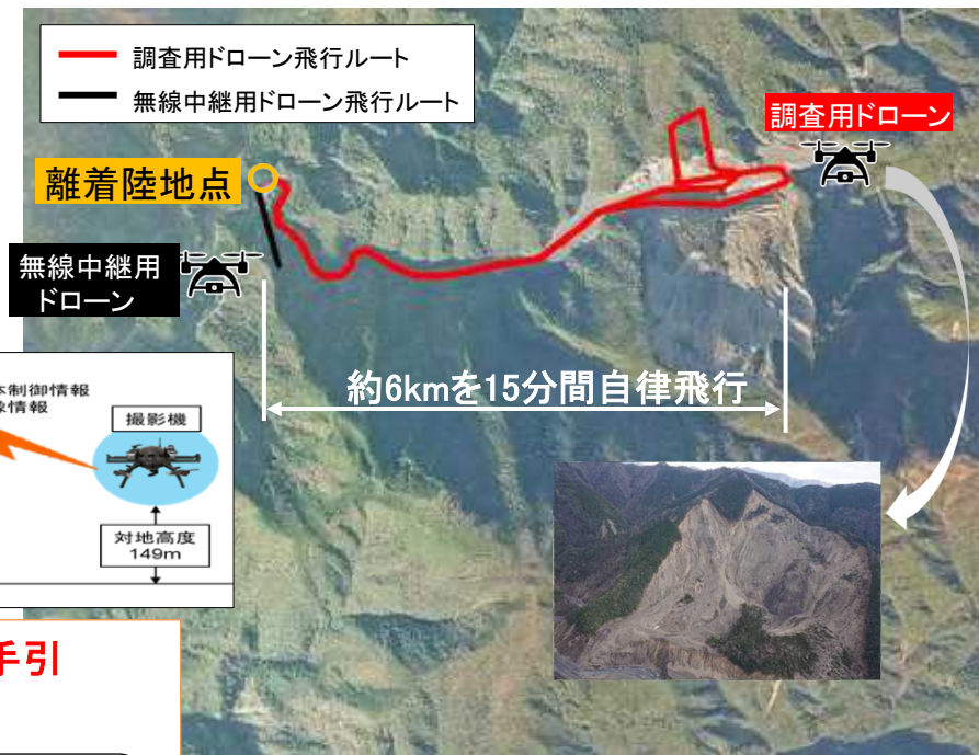
図 UAVの飛行ルートと撮影画像の例 (奈良県十津川村 栗平地区)
