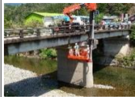
インフラの維持管理(点検作業)
