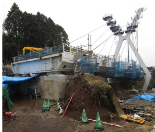
A2橋台改築
