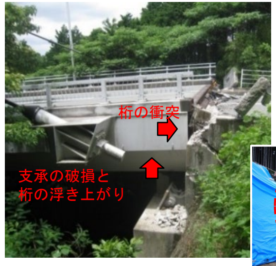
②桁端部のA2橋台との衝突及び浮き上がり
