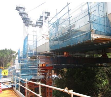
ベントを設置してジャッキアップ後に上部構造の横移動
