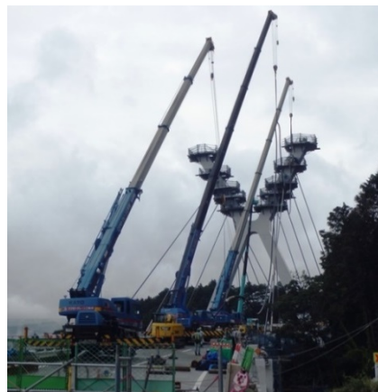
ケーブル交換の状況
