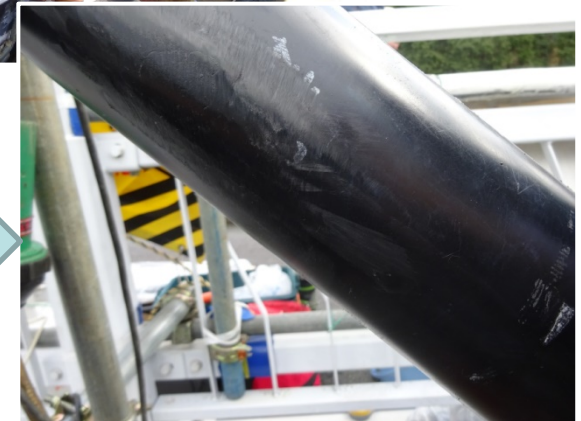
調査孔のPE被覆の補修状況
