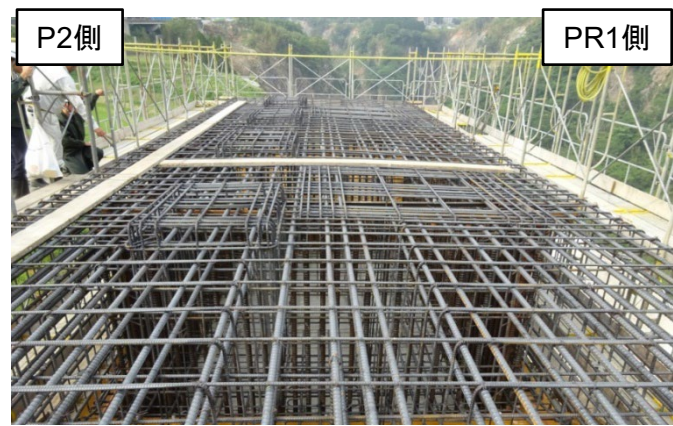
P3橋脚天端橋座部の配筋
