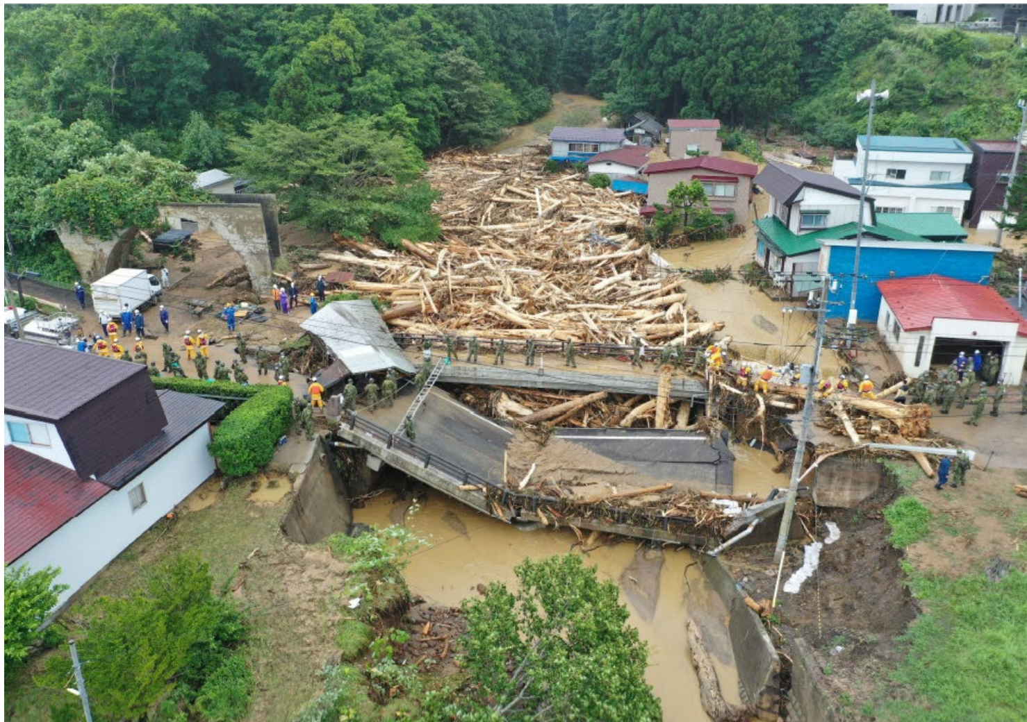
国道279号 小赤川橋（青森県むつ市）
