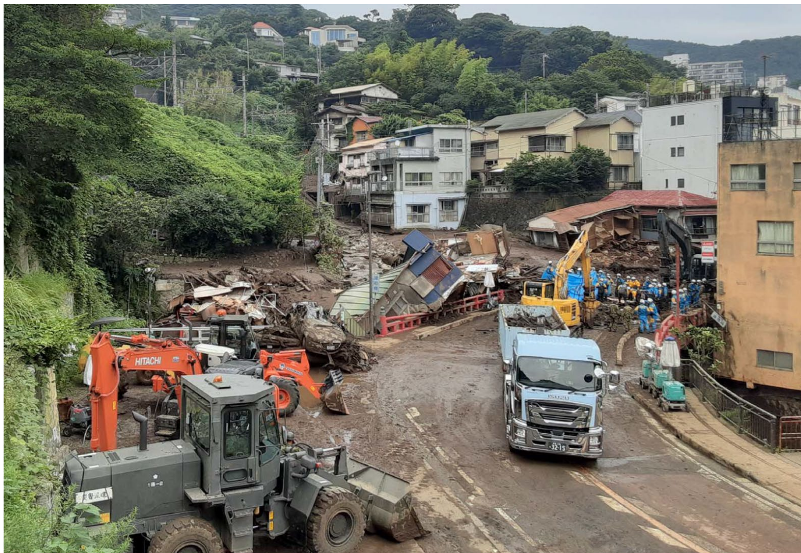
国道135号 逢初橋（静岡県熱海市）
