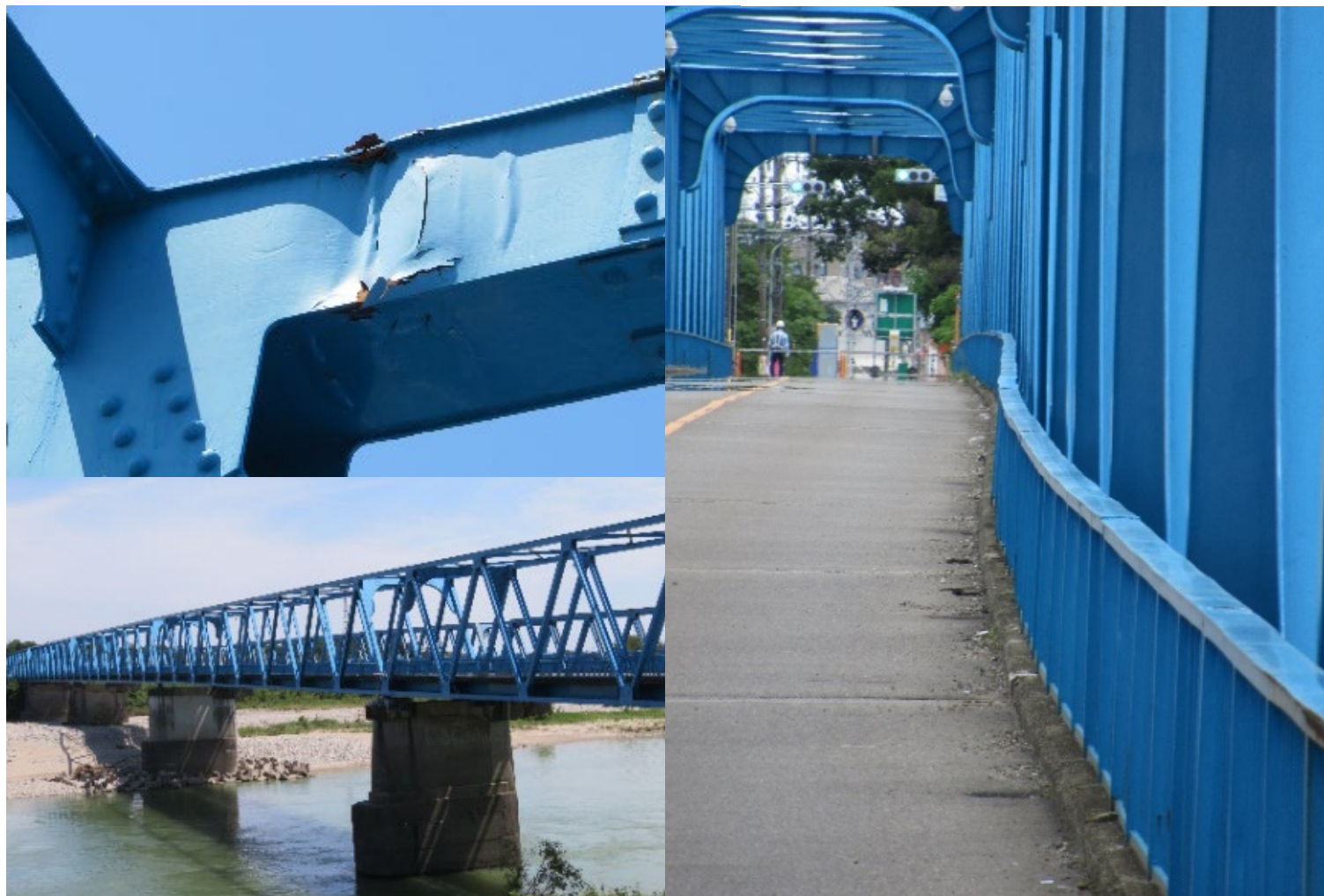
一般県道松原芋島線 川島大橋（岐阜県各務原市）
