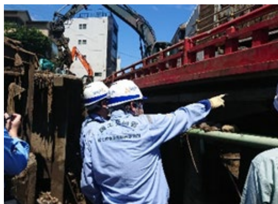
令和3年7月15日 土石流被害を受けた逢初橋に 対し健全度評価を実施
