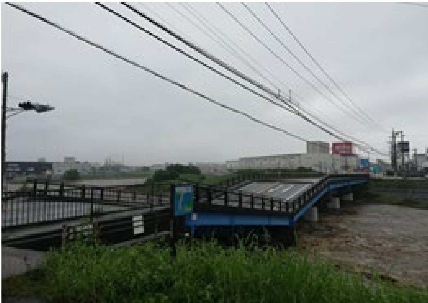
一般県道富士清水線 黄瀬川大橋（静岡県沼津市）
