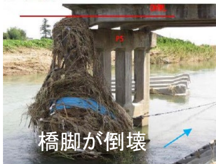
市道O146号線 千部橋(栃木県栃木市)
