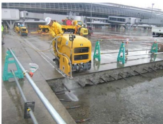
ブロック状に切断する応急復旧の例 (2011年仙台空港)
