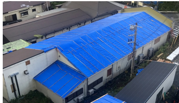
写真 5.1.24 ブルーシートで覆われた 店舗 A の屋根 (2)
