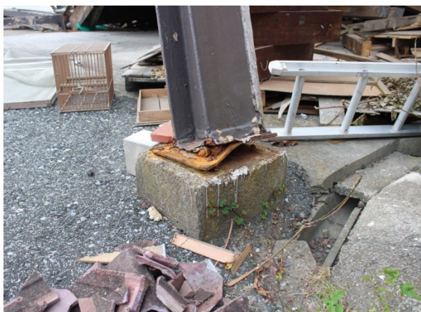
写真 4.1.26 鉄骨造倉庫の柱脚部
