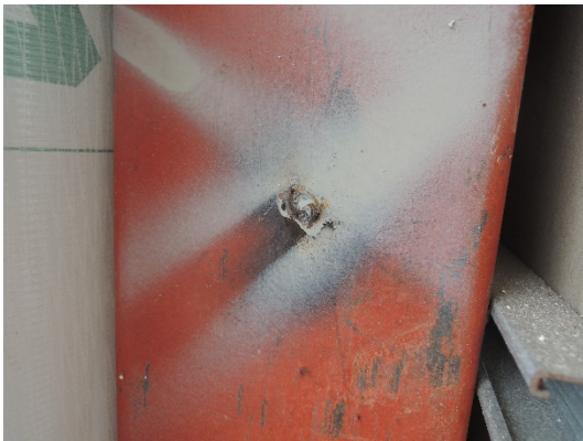
写真 4.3.13 建具と鋼製支持部材との接合部(3)
