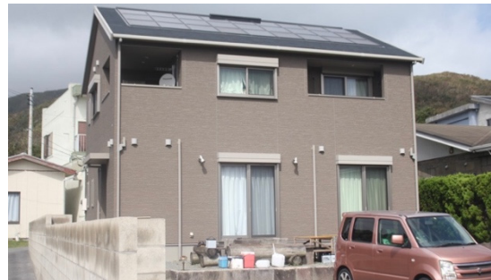
写真 5. 2. 21 無被害の住宅(2)
