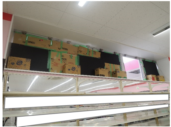
写真 4.1.6 破損したガラスの養生状況
