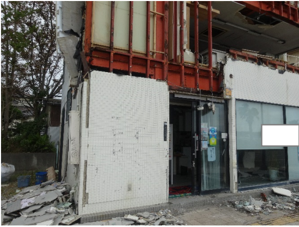
写真 4.3.5 外壁の脱落
