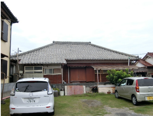
写真 4.3.33 無被害に見える瓦屋根(1)
