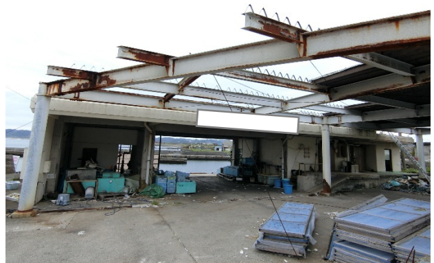
写真 4.3.16 漁港施設 A と同じ敷地内にある建屋
