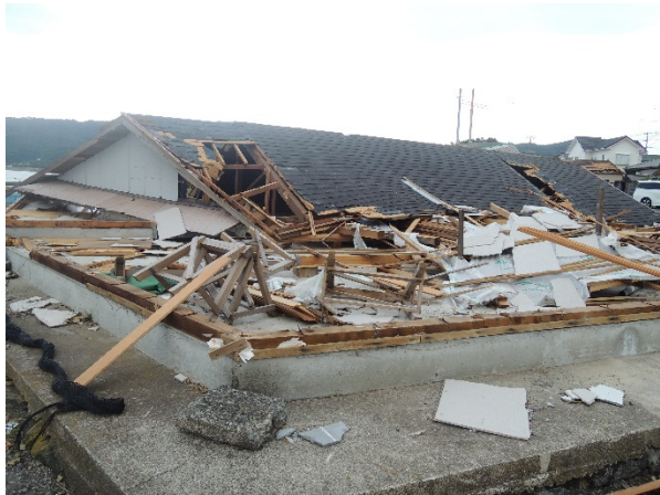
写真 4.1.22 木造倉庫の倒壊
