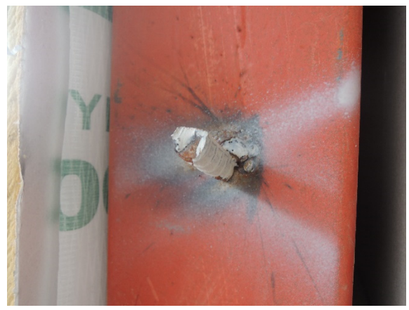
写真 4.3.12 建具と鋼製支持部材との接合部(2)
