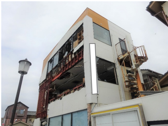
写真 4.3.3 店舗 I の外観
