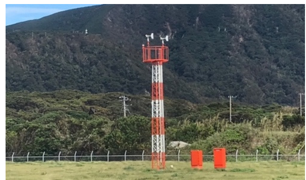
写真 5.2.2 新島空港の風速計(北側)
