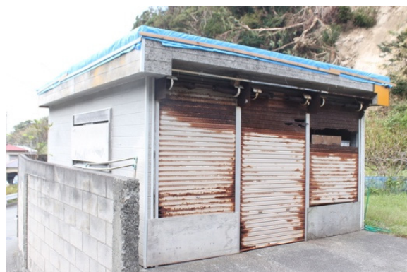
写真 5.1.44 倉庫の屋根被害
