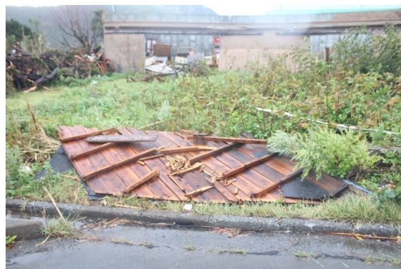
写真 5. 2. 27 飛散した屋根材
