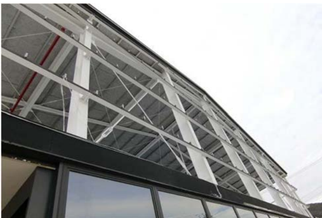
写真4.1.13 外壁材の留め付け部分
