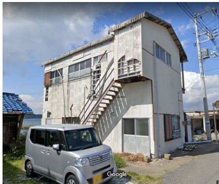
写真 4.3.17 漁港施設 A の被災前の状況*
