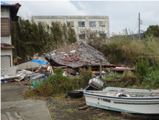
写真 4. 2. 34 倒壊した倉庫(被災後)
