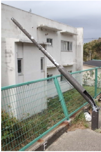
写真 5.1.17 飛来物の衝突により破損したと思われる街灯
