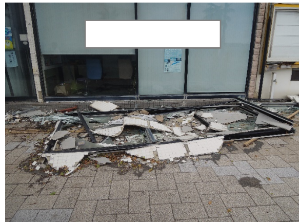
写真 4.3.4 建具の脱落
