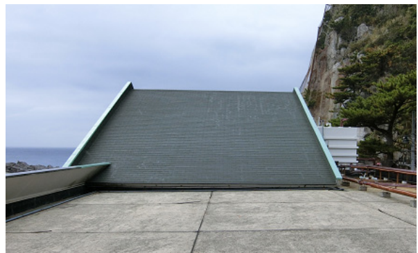
写真 5.1.59 既にアスファルトシングルへの 葺き替えが終わっていた三角屋根部分
