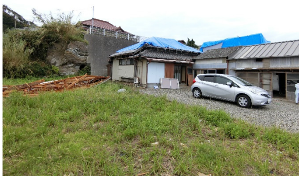
写真 4. 3. 43 北西へ吹き飛んだ木造住宅の屋根
