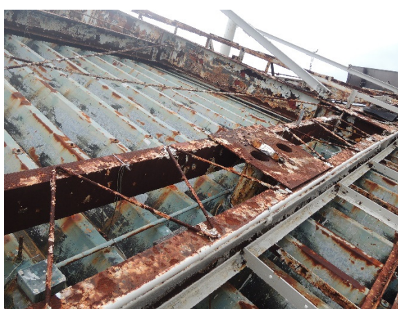
写真 4.3.22 キャノピー上面の状況
