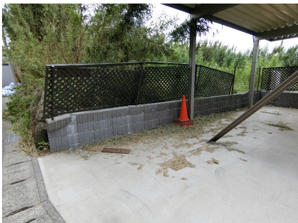
写真 4. 3. 27 3段積みのブロック塀全体の様子
