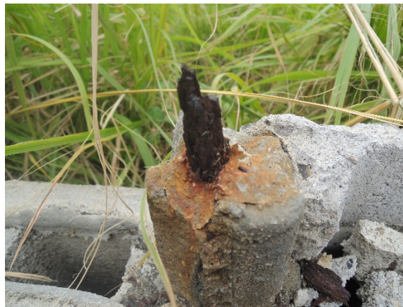
写真 4. 3. 26 鉄筋の状況
