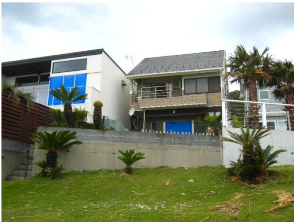
写真 4.3.74 写真 4.3.72 の住宅の 西に隣接する住宅
