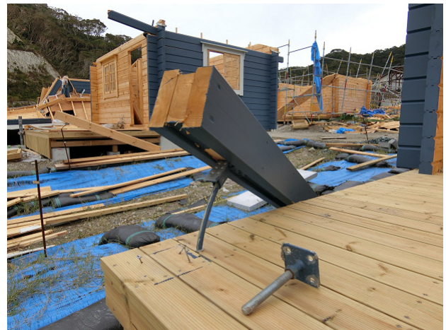
写真 4. 3. 60 オーバーハングの屋根を支える柱の脚部
