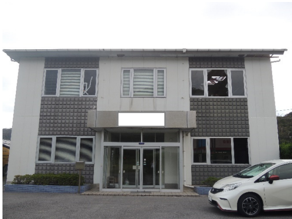
写真 4.1.16 事務所 A の外観
