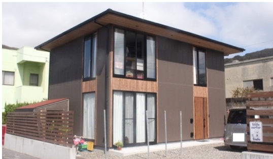
写真 5. 2. 20 無被害の住宅(1)
