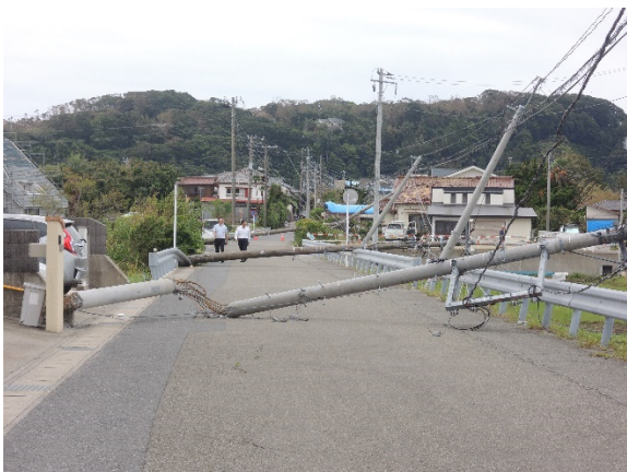
写真 4.2.13 電柱の折損
