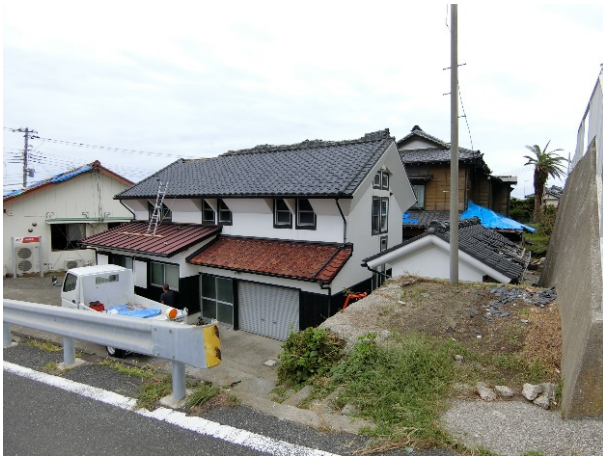
写真 4.3.35 最近改修したとみられる瓦屋根の棟
