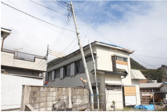
写真 5.1.40 住宅の屋根被害と折れた電柱
