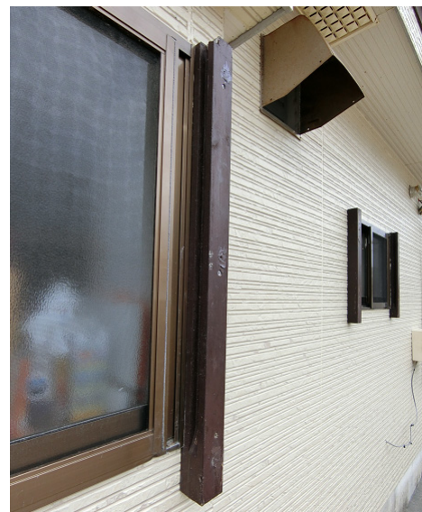
写真 5.1.22 開口部の防御居板の受け材
