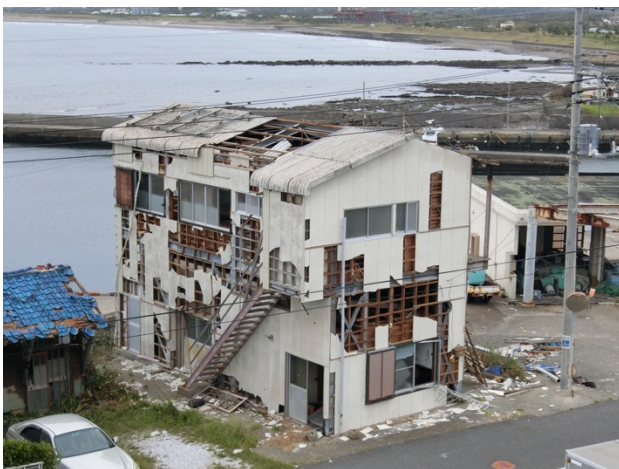
写真 4.3.15 漁港施設 A の外観
