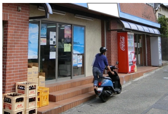
写真 5.1.39 店舗 B の庇の被害
