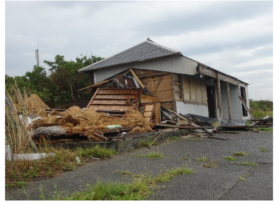
写真 4. 2. 38 木造住宅の上部構造の倒壊
