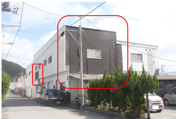
写真 5.2.8 住宅の外壁被害の応急的な補修
