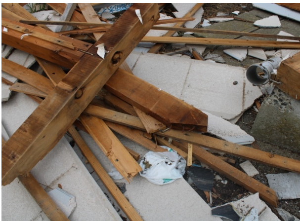
写真 4.1.24 木造倉庫に用いられていた筋かい
