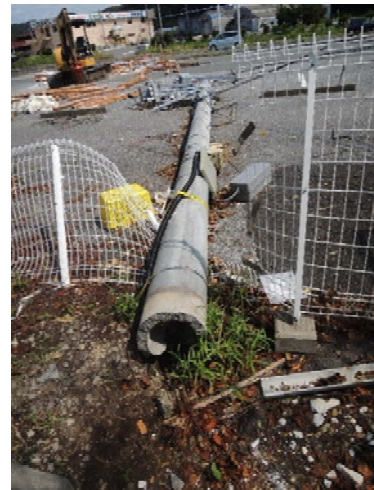
写真 4.2.8 電柱の折損
