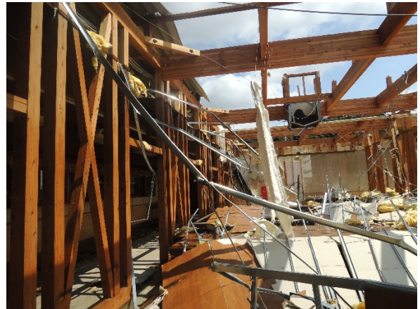
写真 4.2.6 店舗 F の屋内の状況
