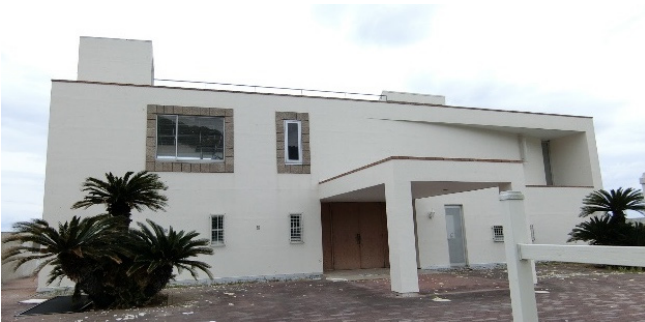
写真 4.3.69 無被害のように見える鉄骨造建築物
