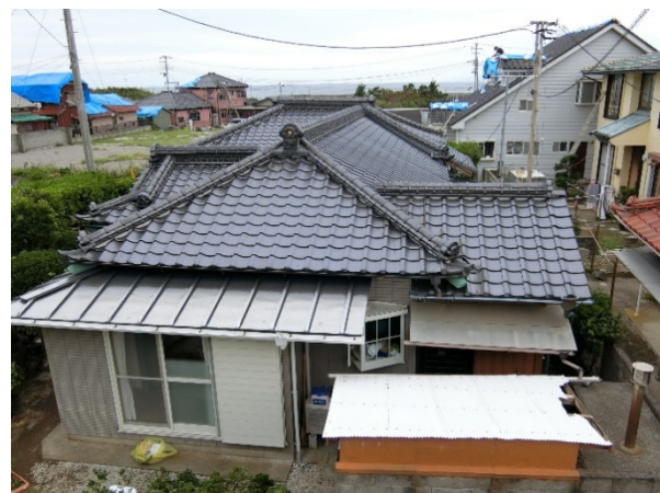
写真 4.3.34 無被害に見える瓦屋根(2)
