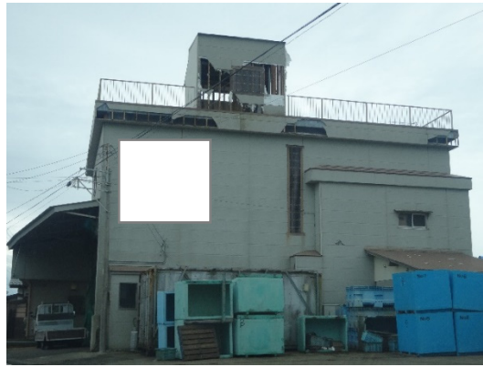
写真 4. 2. 29 塔屋の被害
