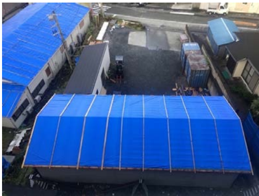
写真 5. 1. 33 補修された宿泊施設 A の倉庫
