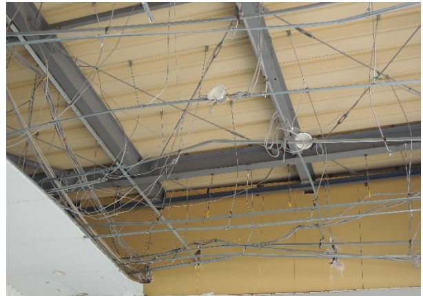
写真 4.3.2 軒天井の鋼製下地材の状況
