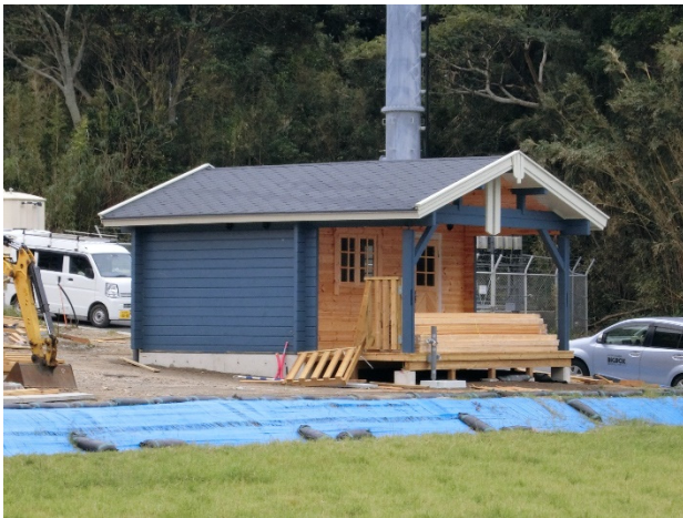
写真 4. 3. 59 被害が軽微であったログハウス
