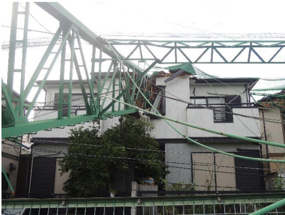
写真 3.12 近隣の住宅の被害(2)
