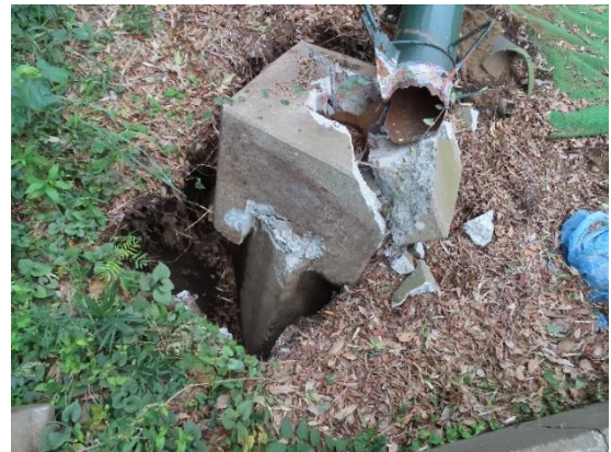
写真 3.27 柱脚の折損
