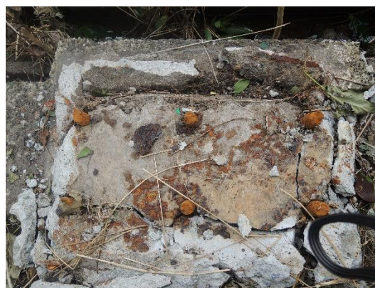
写真 3.9 柱脚ベースプレートの設置跡
