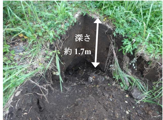
写真 3.25 柱脚の埋め込み跡
