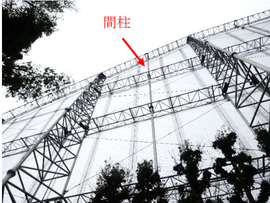
写真 3.28 無被害の鉄柱と間柱
