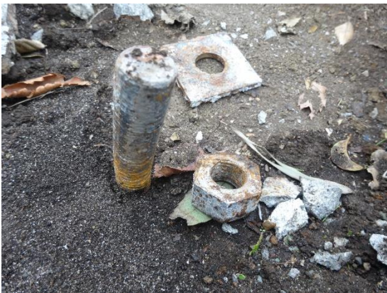
写真 3.20 発錆していないアンカーボルト
