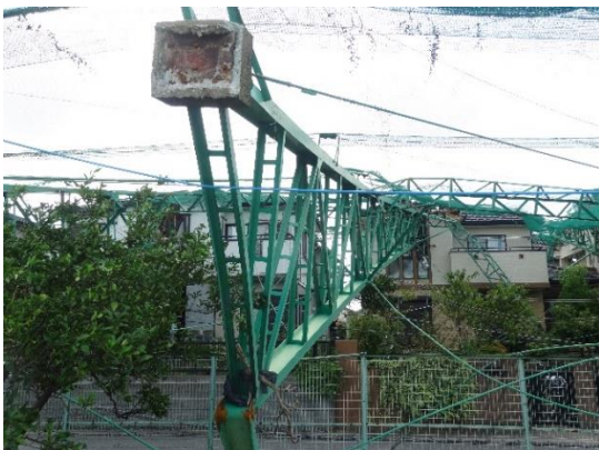
写真 3.8 隣接する住宅への倒壊状況
