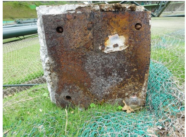
写真 3.19 ベースプレートとアンカーボルト(2)
