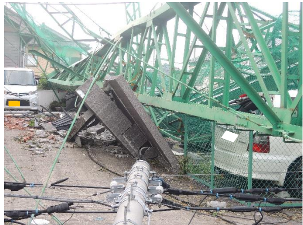
写真 3.13 ブロック塀、電柱、乗用車の被害
