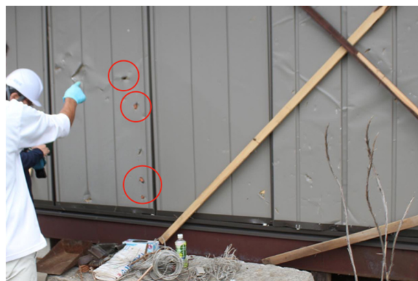
写真 3.1.16 瓦が突き刺さった雨戸
