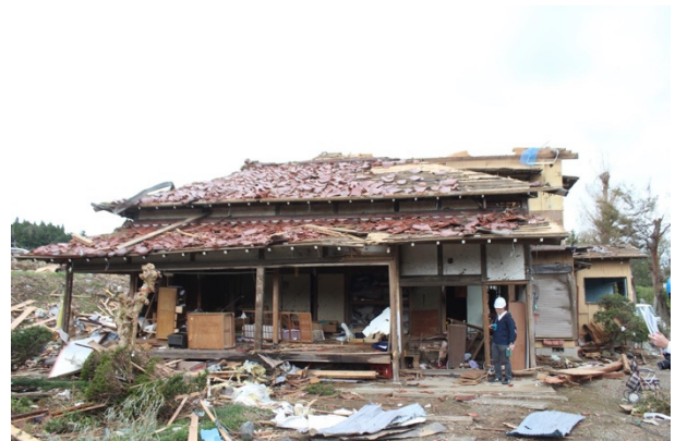
写真 3.1.10 住宅 B の外観 (南面)
