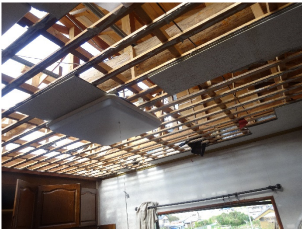
写真 3. 1. 35 小屋組が残っている 屋根の範囲の状況
