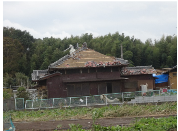
写真 3. 1. 49 住宅 K の屋根の状況 (北東側)
