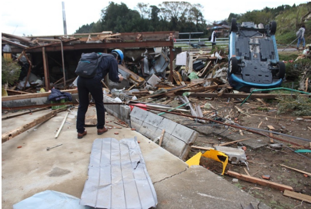
写真 3.3.3 飛散した車庫 A と転覆した自動車 (北面から)
