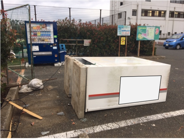
写真 3. 3. 24 自動販売機の転倒
