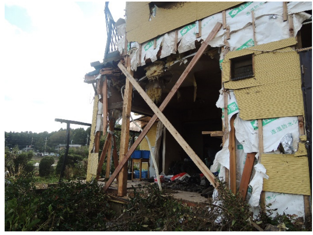
写真 3. 1. 42 損壊した壁面の応急措置の状況
