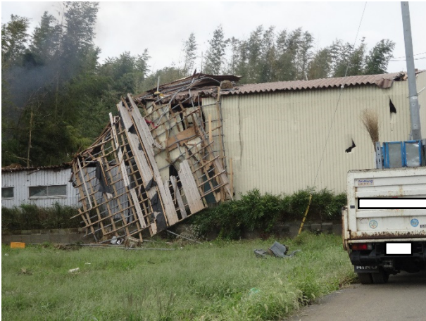
写真 3.3.11 倉庫Bの外観
