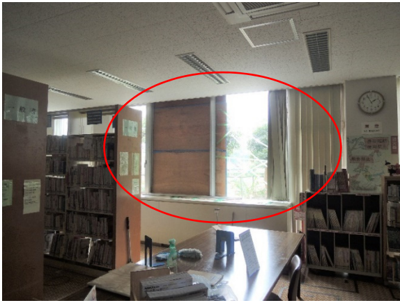
写真 3.2.3 写真 3.2.2 に示すガラスの養生状況
