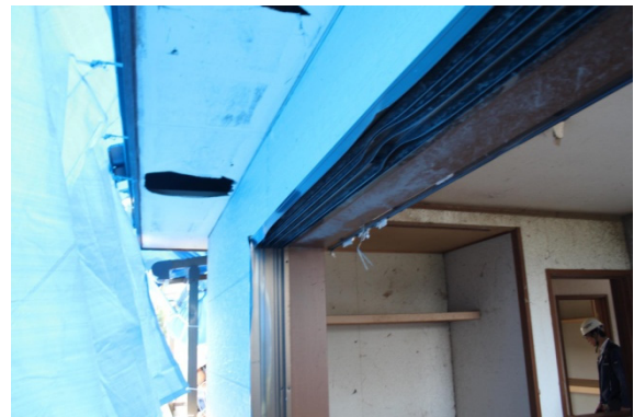
写真 3.1.26 2 階南側の窓と軒天井
