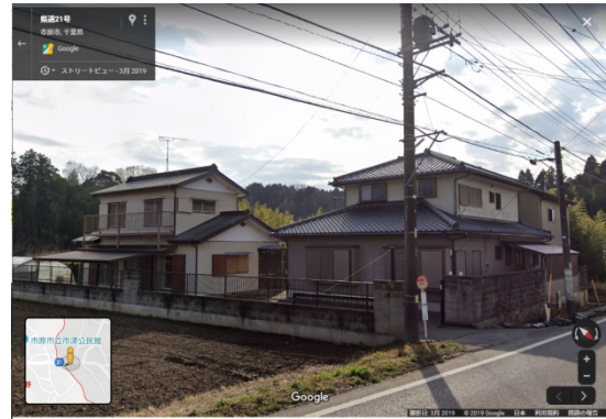
写真 3.1.30 写真 3.1.29 の被災前の状況 (Google ストリートビュー (2019 年 3 月撮影) より)
