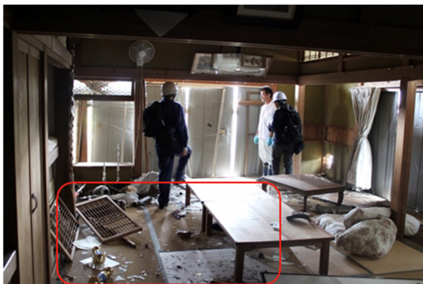
写真 3.1.17 ガラス等が飛散した室内
