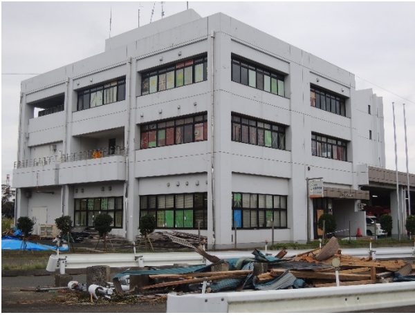
写真 3. 2. 13 消防署の外観
