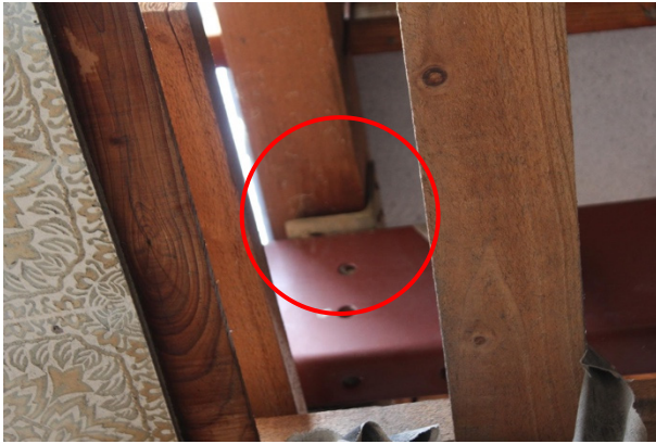
写真 3.1.7 小屋組の L 型金物
