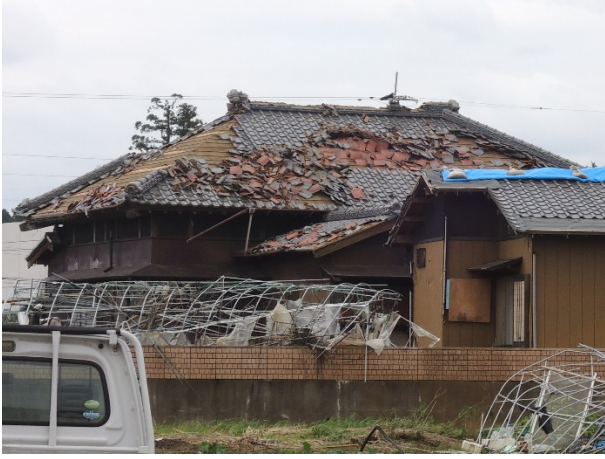
写真 3. 1. 50 住宅 K の屋根の状況（北西側）
