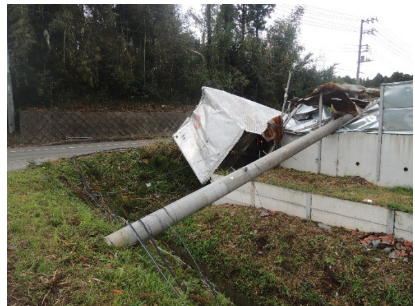
写真 3.3.23 電柱の折損
