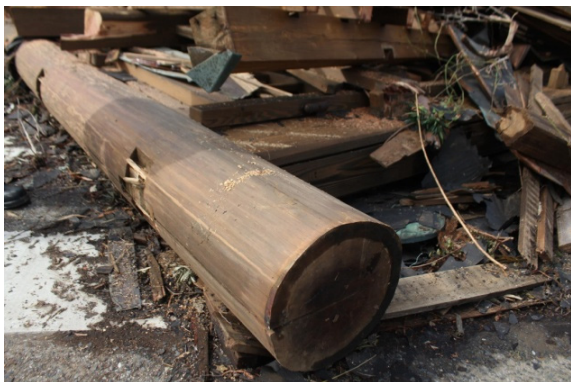
写真 3. 3. 17 倒壊した門の部材
