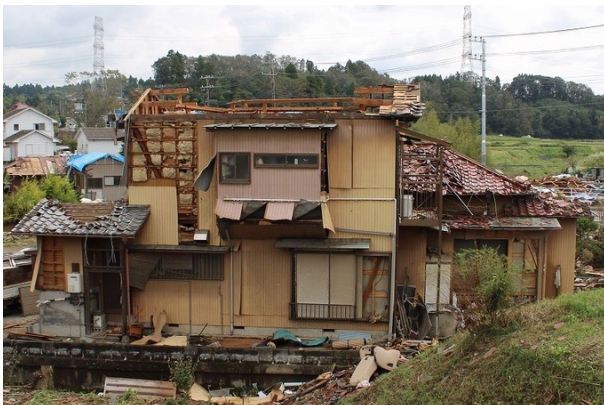
写真 3.1.9 住宅 B の外観 (北面)
