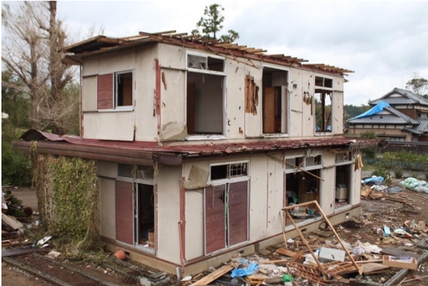
写真 3.1.1 住宅 A の外観 (南西面)
