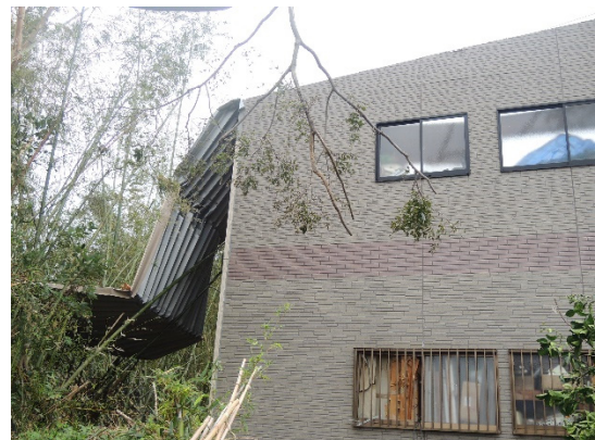
写真 3.3.10 折板屋根材の状況
