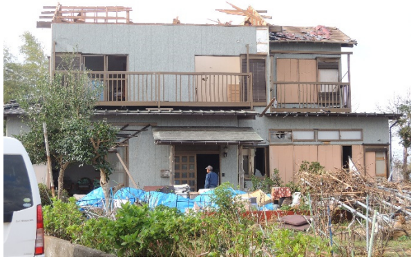
写真 3. 1. 33 住宅 H の外観
