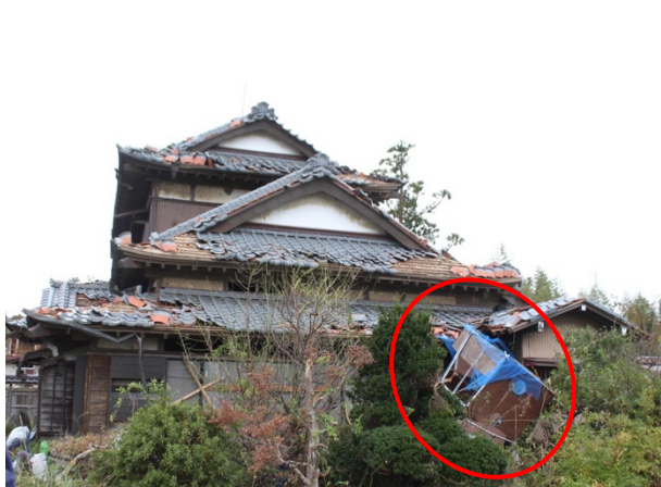
写真 3.1.13 住宅 C の外観 (東面)
