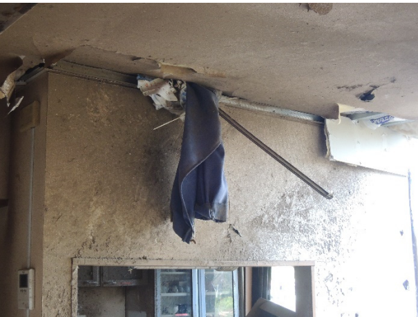
写真 3. 1. 43 写真 3. 1. 42 の室内側の状況
