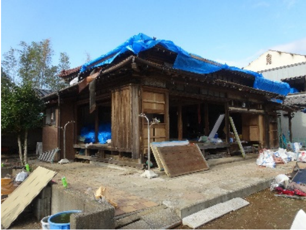
写真 3. 1. 38 住宅 I の外観
