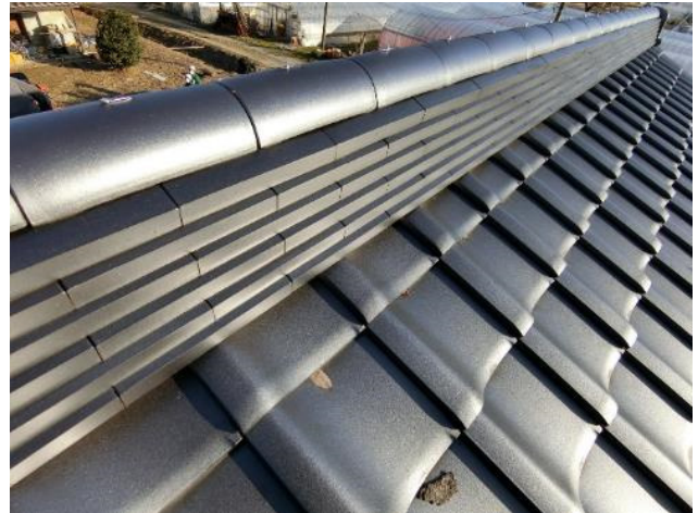
写真 2.6.4 損傷が無い棟部
