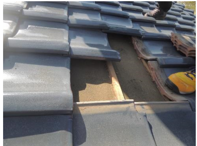
写真 2.1.2 椽瓦を一部撤去した状況
