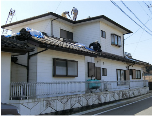
写真 2.9.9 一部始まっていた屋根瓦の修復工事
