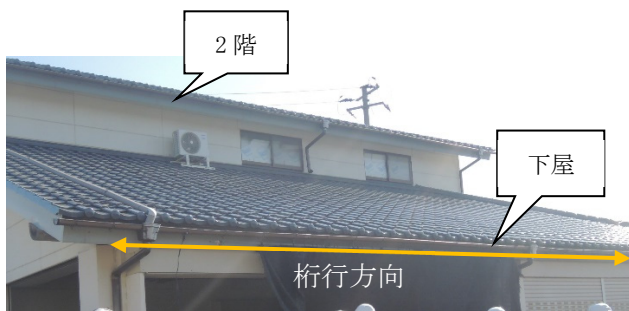
写真 2.1.1 物置の屋根の外観（西側から見る）
