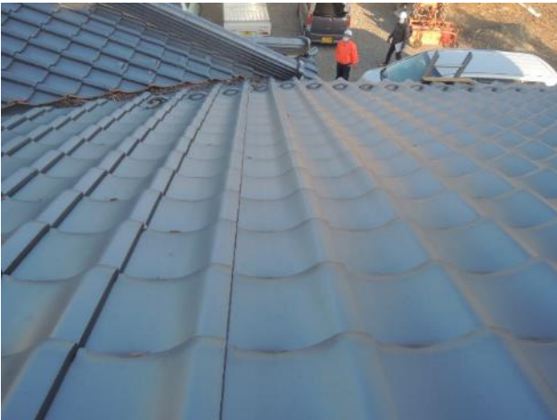
写真 2.6.3 損傷が無い平部
