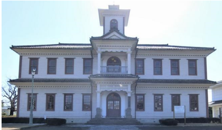
写真 3.1.9 外観上無被害に見えたが、被害を受け臨時休館していた国指定重要文化財の旧伊達郡役所
