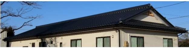
写真 2.6.1 住宅⑥の屋根の外観 1
