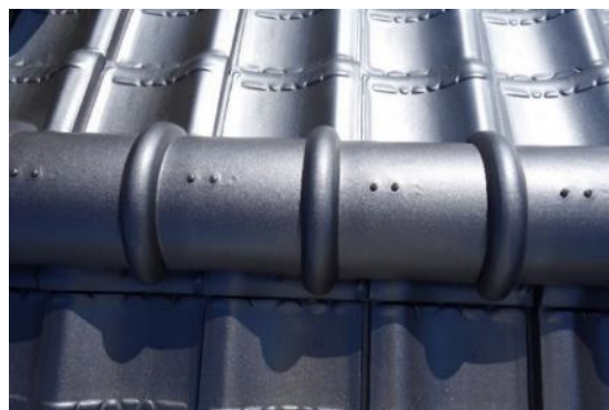
写真 2.2.2 平屋部分の緩勾配の棟まわり
