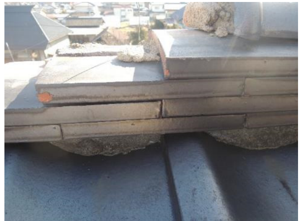
写真 2.5.2 棟部ののし瓦と冠瓦の状況
