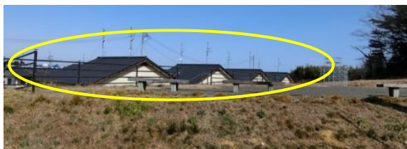
写真 2.9.6 南北方向棟が無被害の町営住宅
