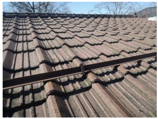
写真 2. 2. 4 セメント瓦による 2 階部分の状況
