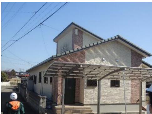
写真 2.9.3 住宅②の周辺で確認したガイドライン工法によるものと思われる瓦屋根
