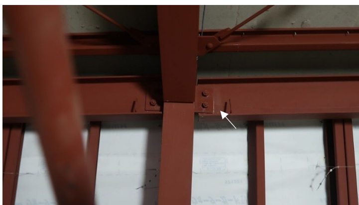
(c) 鉄骨梁の端部における回転
