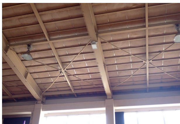
(a) ブレースの変形
