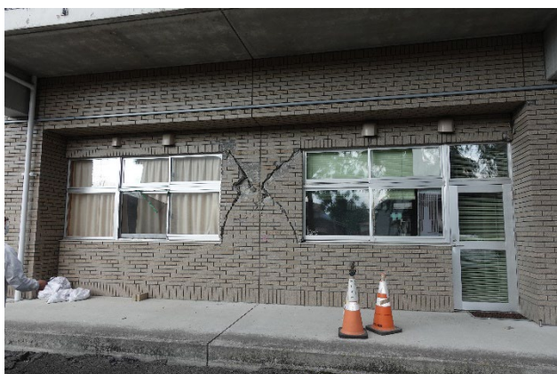
図 4.1.2 (c) 非構造壁のせん断破壊
