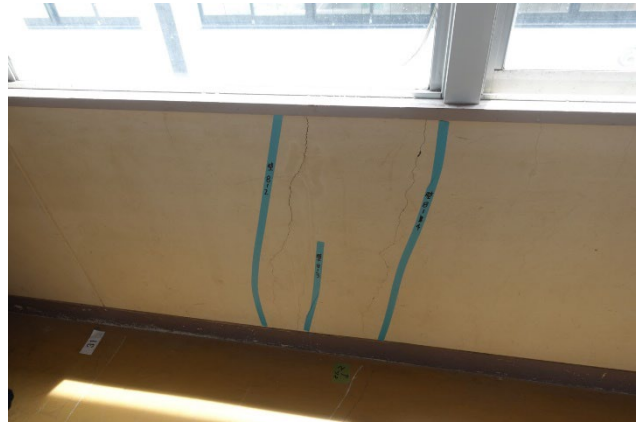
(c) 窓直下の腰壁部分
