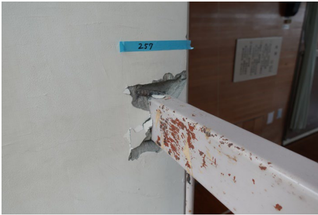
(b) RC 柱と手すりの接合部分
