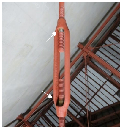
(b) ターンバックルの増し締め
