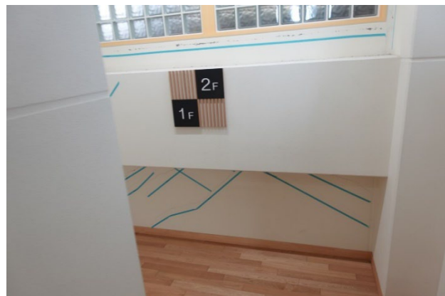
(b) 階段室壁 (北面)
