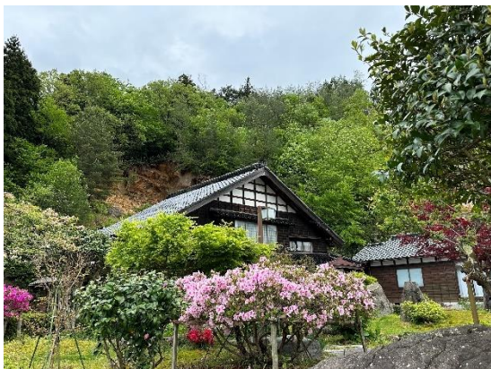
写真 6.2.23 大規模な斜面崩壊で危険な住宅
