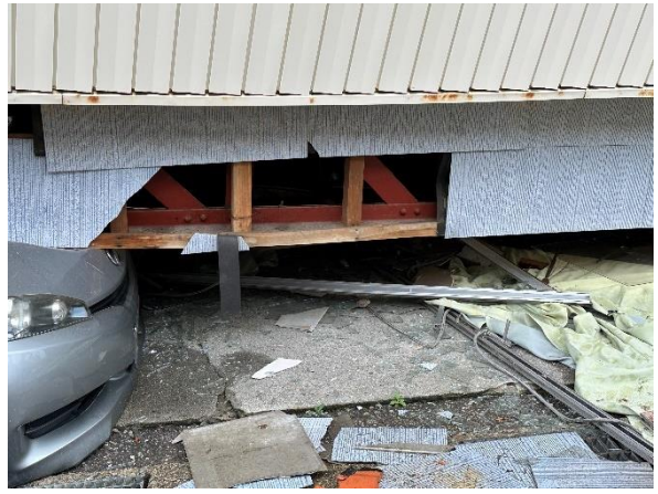
写真 6.1.2 横架材に使用されている鋼製部材
