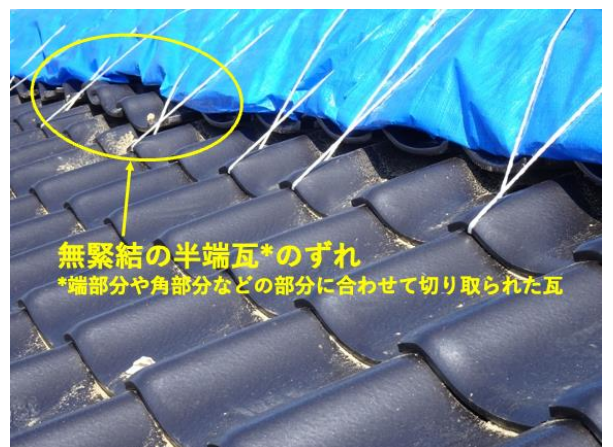
写真 8.2.4 半端瓦の移動
