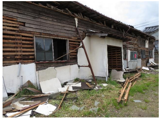
写真 6.2.17 写真 6.2.16 の倉庫の鋼製バットレス
