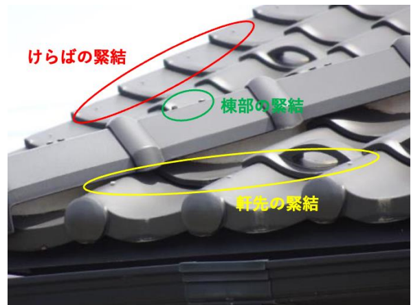
写真 8.4.2 軒先・けらば・棟部の緊結状況
