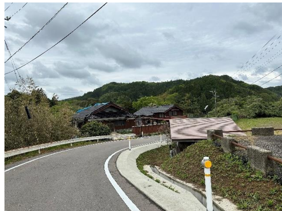
写真 7.3.2 近隣の屋根瓦の被害
