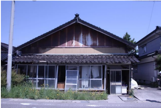
写真 6.4.1 住宅の傾斜：1/20 rad
