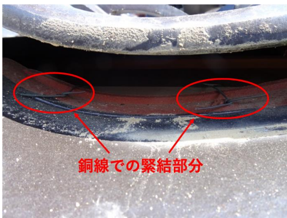
写真 8.2.3 平瓦の緊結状況
