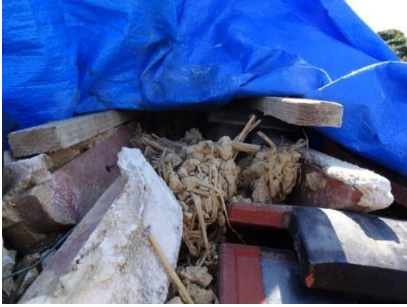
写真 8.2.5 棟部の施工状況
