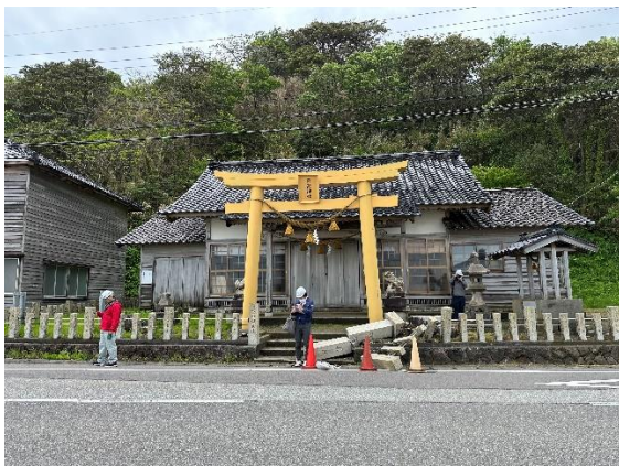
写真 7.3.3 石棒状の柵等の倒壊・社殿無被害
