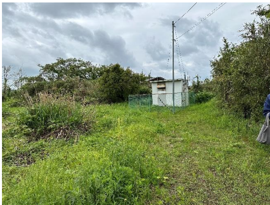
写真 7.3.1 地震計設置状況
