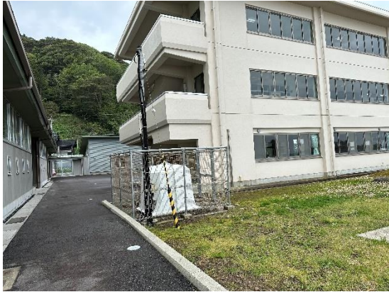
写真 7.4.1 地震計設置状況
