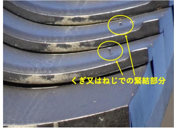
写真 8.2.6 けらばの緊結状況
