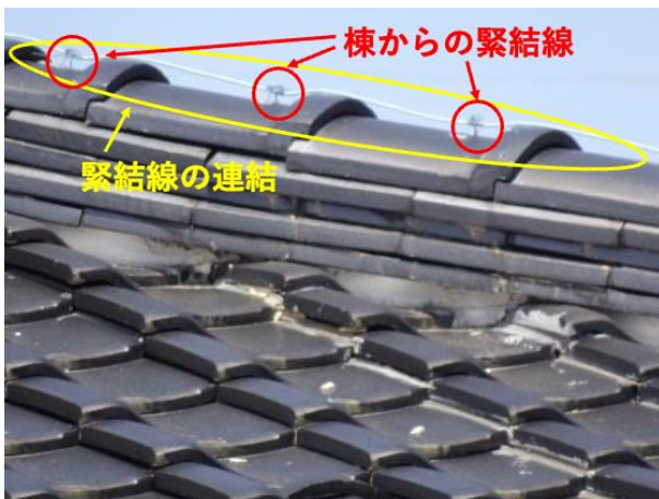
写真 8.5.5 棟部の施工状況 (珠洲市正院町正院)
