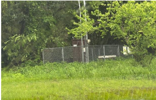
写真 7.2.1 地震計設置状況
