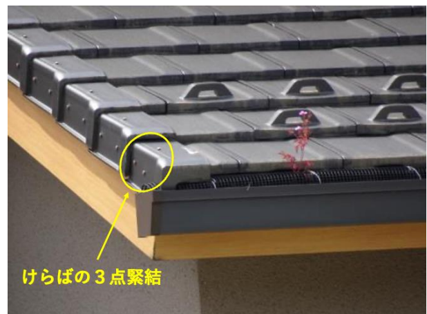
写真 8.4.4 瓦の緊結状況
