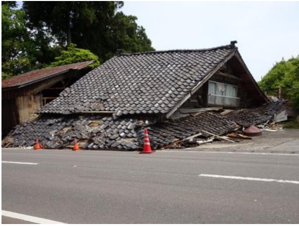
写真 8.5.7 倒壊した建築物 (珠洲市三崎町)
