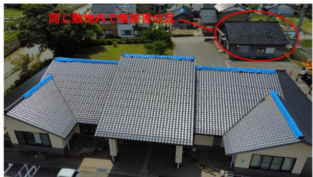
写真 8.2.2 屋根全体と古い倉庫(右上)
