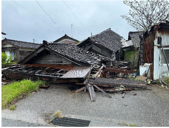
写真 6.2.4 写真 6.2.1 近傍の倒壊住宅 2
