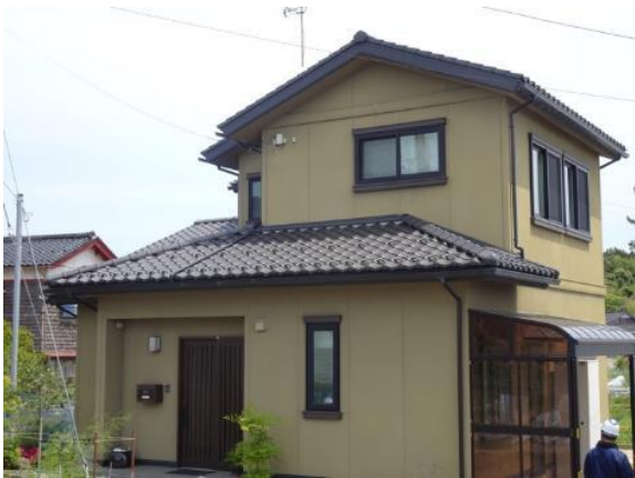
写真 8.4.1 住宅Aの外観
