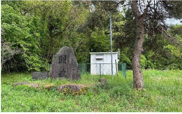
写真 7.5.1 地震計設置状況
