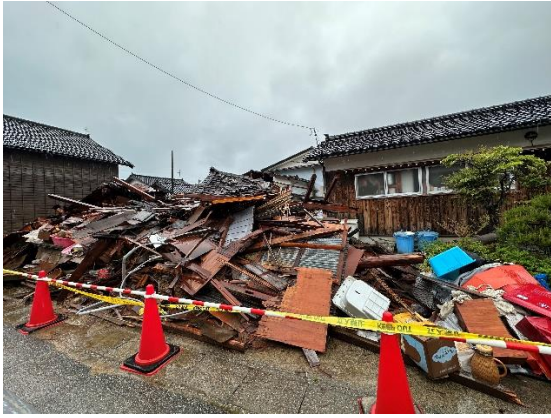
写真 6.2.9 余震で倒壊した木造廃工場建築
