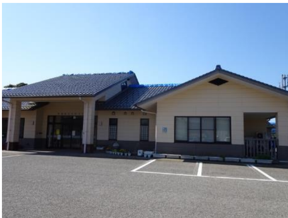
写真 8.2.1 建築物の外観
