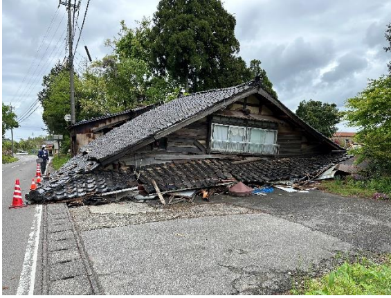
写真 6.3.1 三崎町二本松の倒壊住宅
