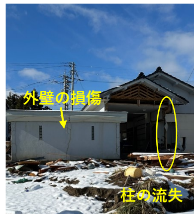
図 6.3.6 外壁の損傷と隅柱の流失
