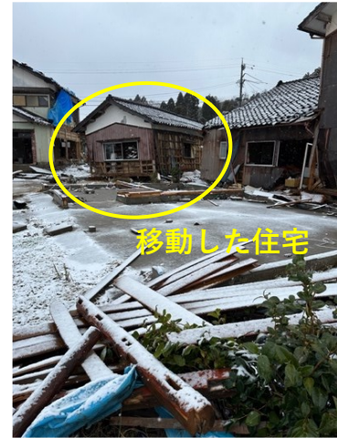
図 5.5.3 移動した住宅(2)
