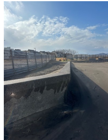
図 4.2.5 損傷のない防砂柵 (海側に堤防あり)
