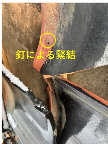
図 6.2.18 瓦の緊結状況
