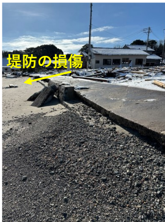
図 6.3.7 堤防の損傷
