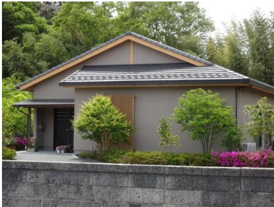
図 5.4.8 令和5年5月の地震後の状況 (F形瓦) 6)
