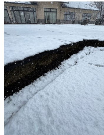
図 5.4.3 正院公民館付近の地割れ
