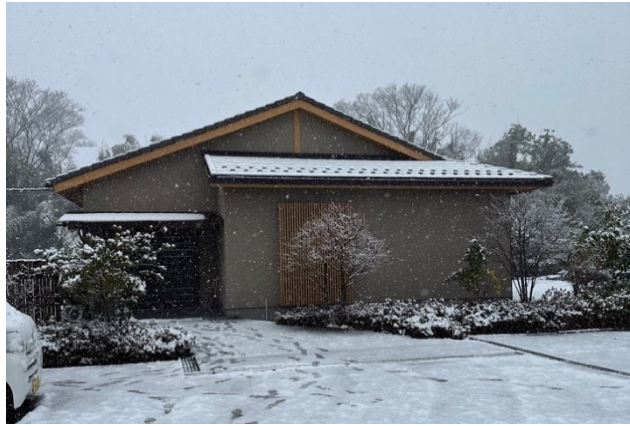
図 5.4.7 ガイドライン工法による住宅(F形瓦)
