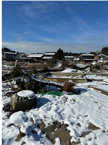
図 6.3.2 流失した住宅(2)
