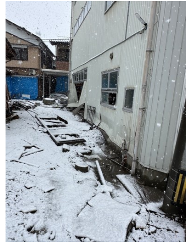
図 5.3.3 外壁の損傷
