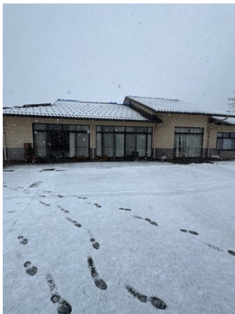
図 5.4.1 正院公民館の被害状況
