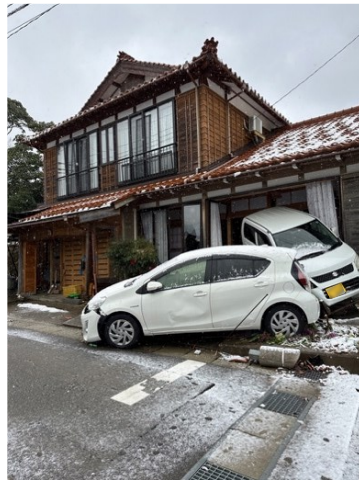
図 5.5.4 津波による車の移動
