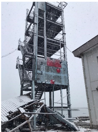
図 5.3.6 津波避難施設の外観(陸側からの撮影)
