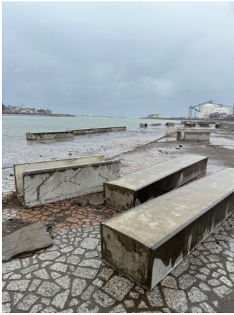
図 4.1.1 コンクリート製のブロックの移動
