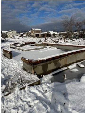
図 6.2.4 建築物の流失(2)
