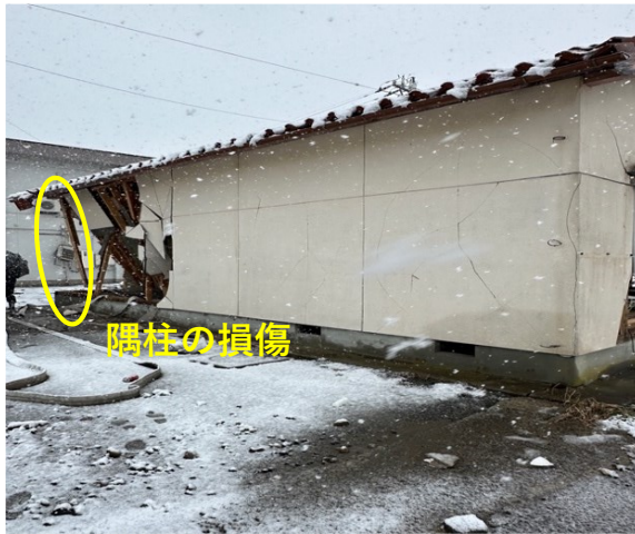
図 5.3.4 津波の正圧による損傷
