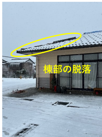
図 5.4.2 棟部の被害
