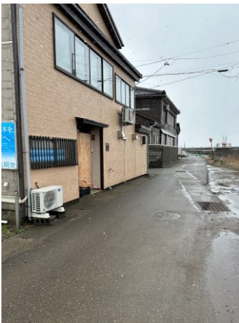
図 4.1.4 床上浸水したと見られる住宅周辺
