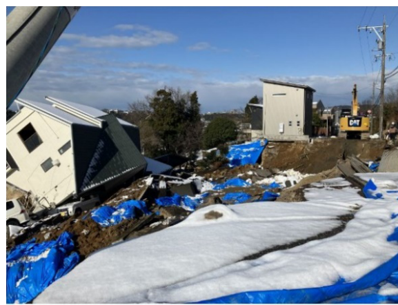
写真 4.2 崩壊した斜面の状況(2)
