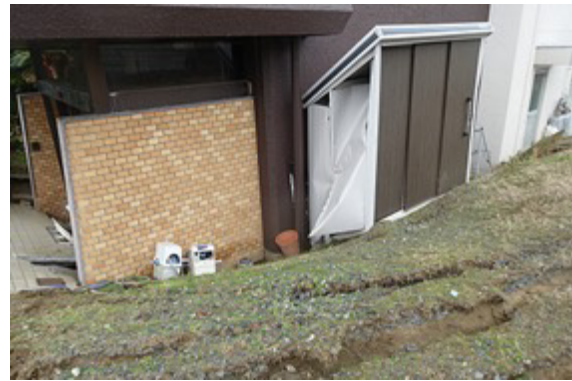
写真 5.5 正面入口付近の状況（周辺地盤）
