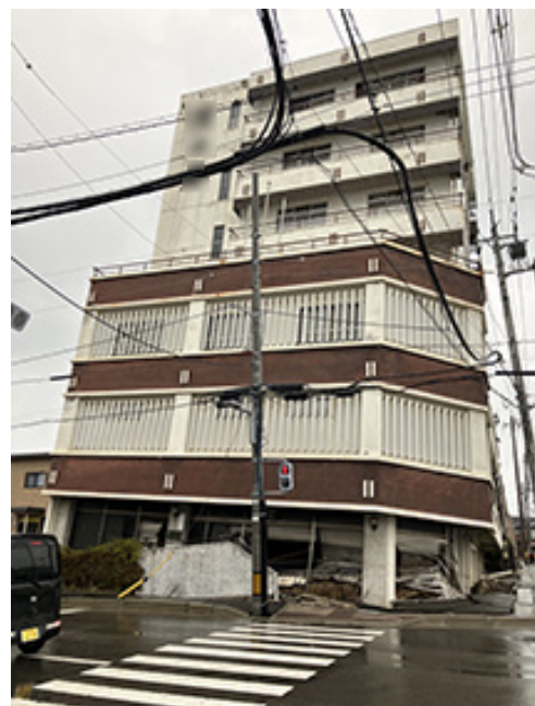
写真 7.2 建物全景（南側から撮影）
