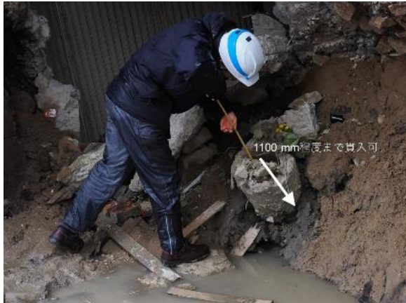
写真 6.5 露出した杭頭
