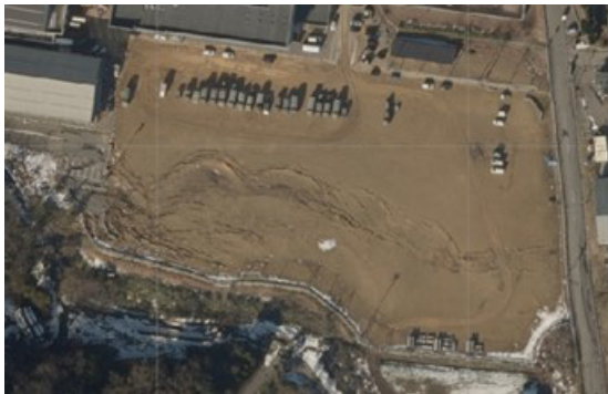
写真 11.1 校庭の地割れ全景 11)
