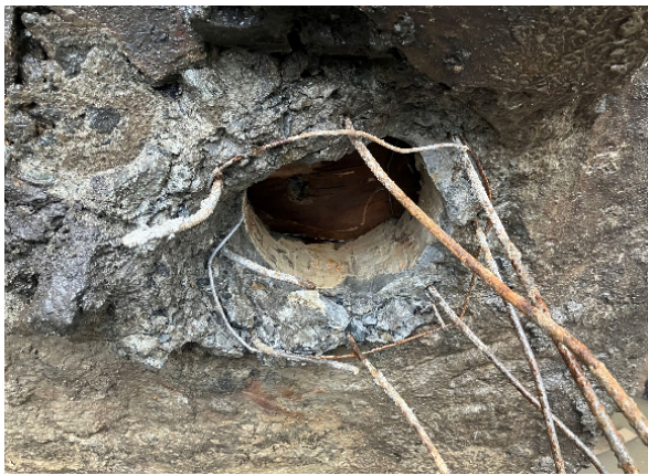
a) パイルキャップの木片
