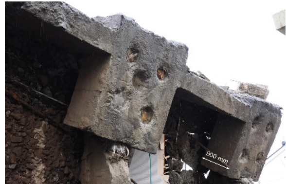
写真 6.4 パイルキャップ
