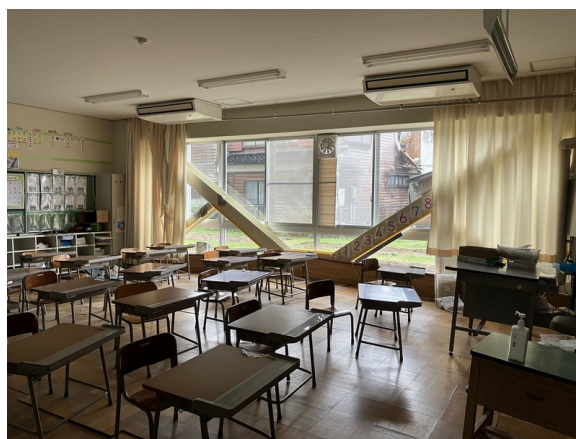
写真 8.2 1 階での床の盛り上がり
