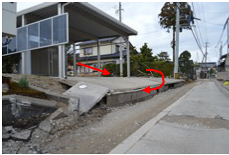
k) 側方流動と側溝の回転
