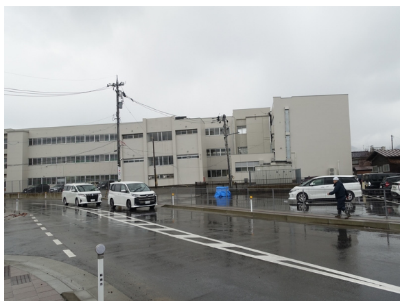
写真 8.1 C 小学校の外観
