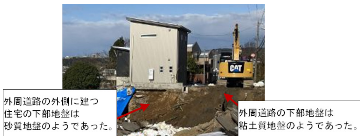
写真 4.5 斜面崩壊エリアの地表面（写真 4.2 のアップ）
