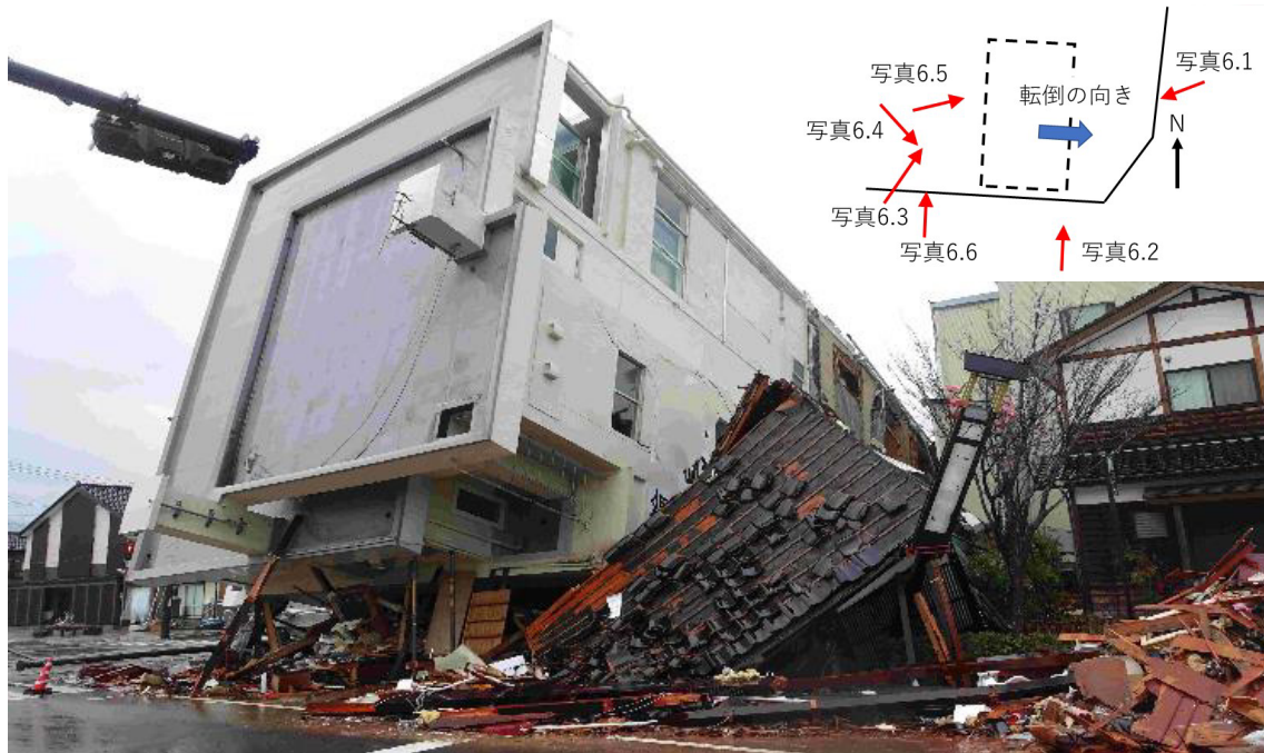
写真 6.1 転倒した建物（東側から撮影）
