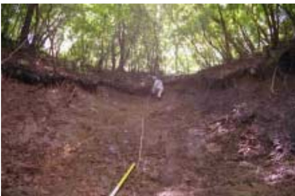
写真 - 2 土石流の発生場(表層崩壊)
