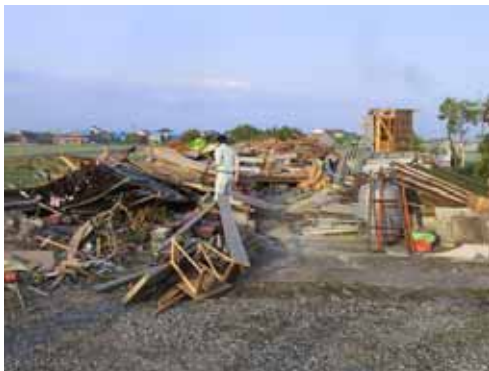
全壊した作業場
