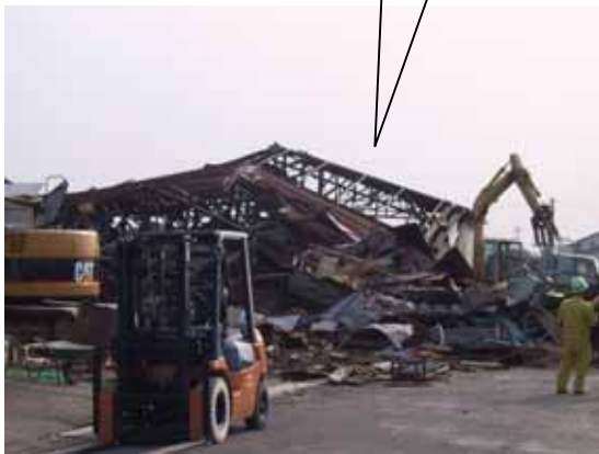
建設資材置場（鉄骨造倉庫の崩壊）
