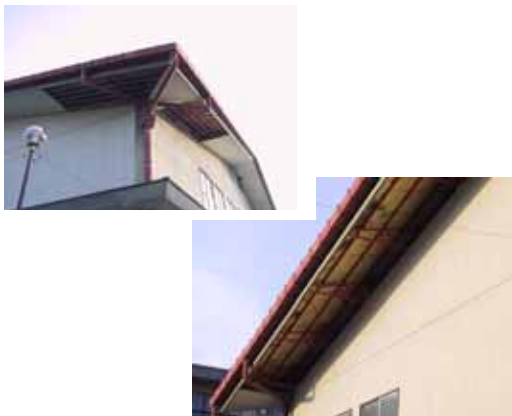
農協施設（屋根剥離、窓ガラス破損、天井落下） 同内部（天井が持ち上げられている）
