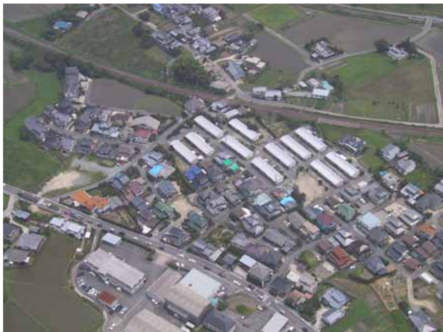
鳥栖市被害地域
