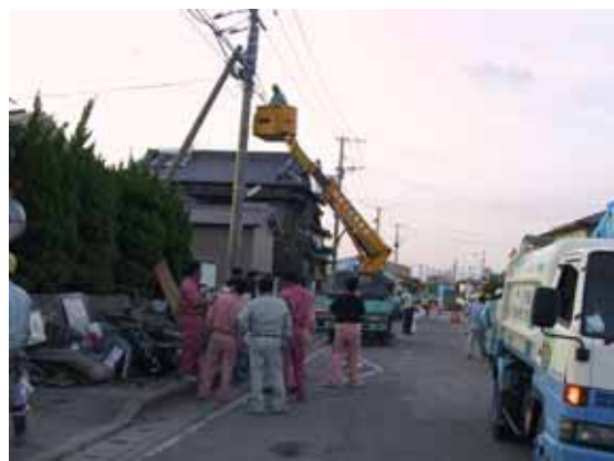
電線等の復旧工事
