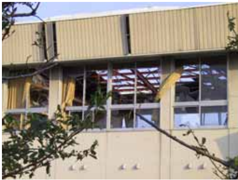
農協施設（屋根剥離、窓ガラス破損、天井落下） 同内部（天井が持ち上げられている）
