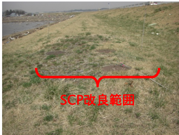
裏小段の状況
