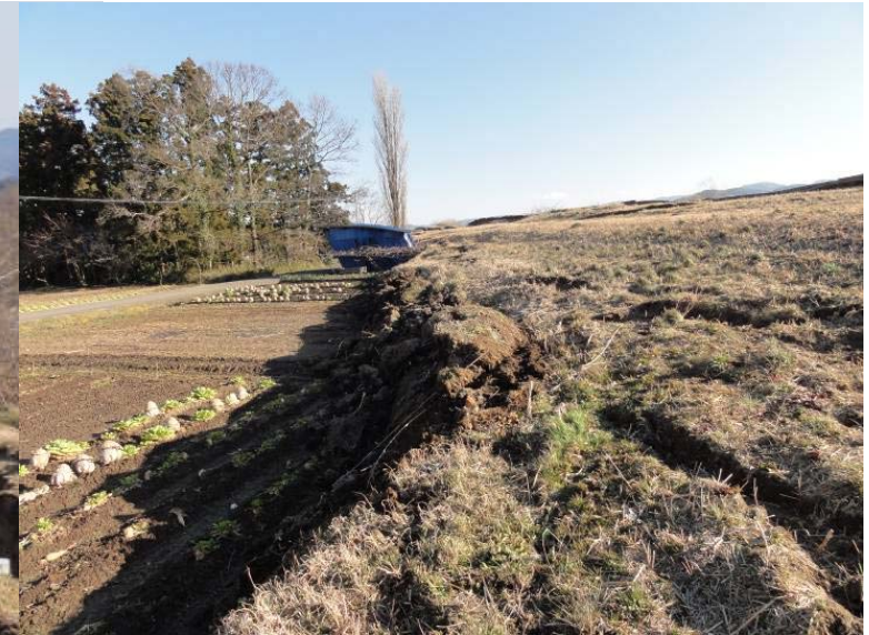
川裏側のり尻付近
