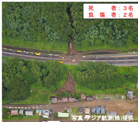
土石流発生状況
