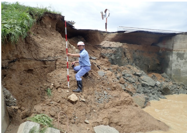
小田川にて堤防の崩壊・決壊状況を調査する国総研職員
