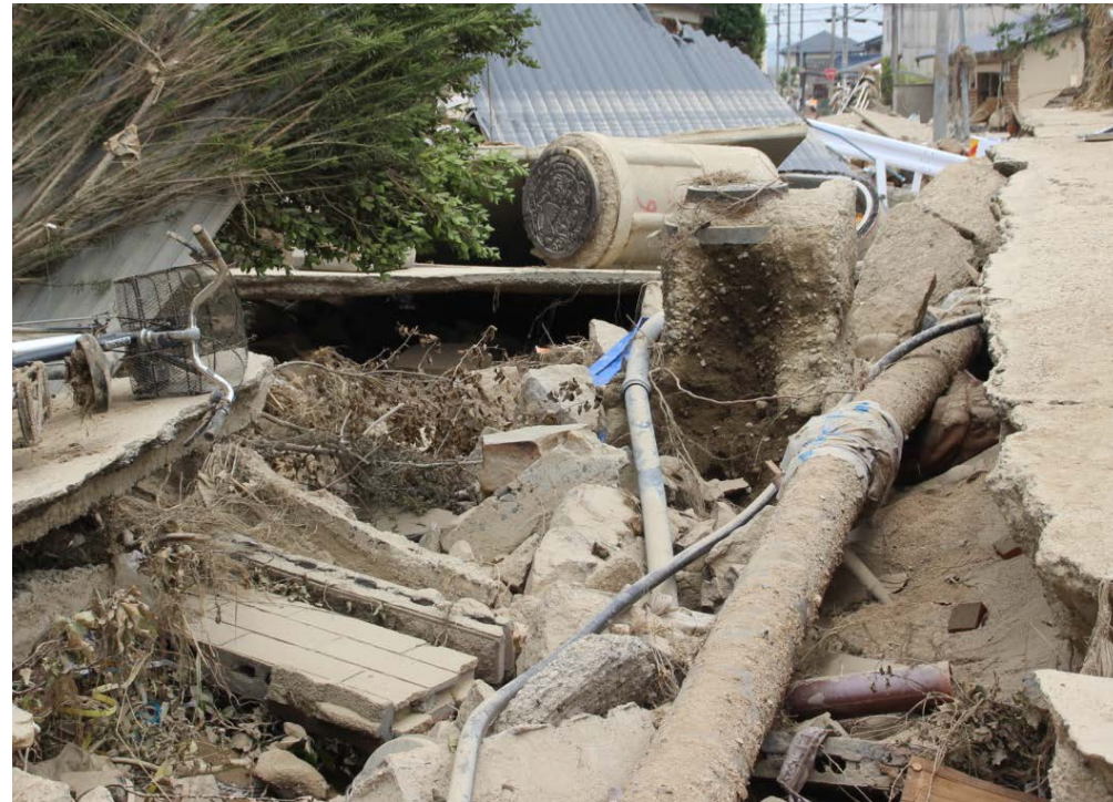
下水管の流失箇所 （写真中央上：被災したマンホール）（7月11日）
