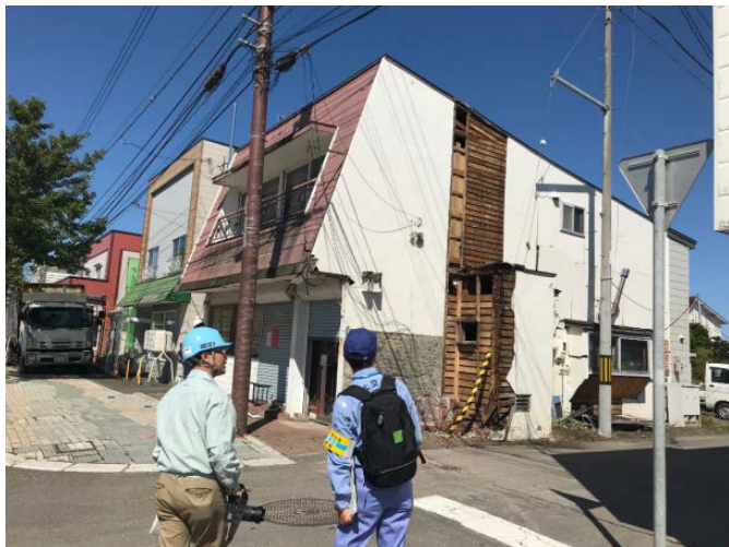
現地調査の状況
