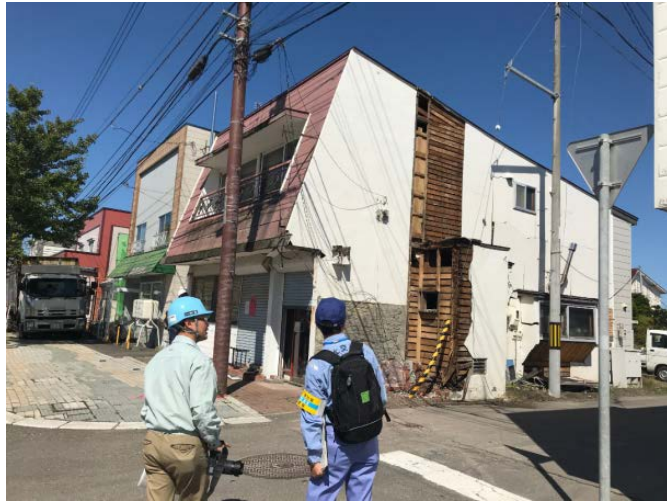
現地調査の状況
