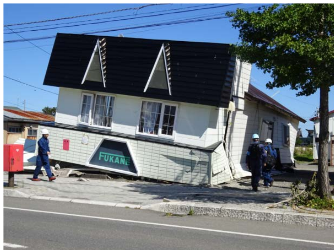
建築物被害の状況①
