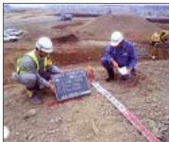
現行：巻き尺による出来形の計測
