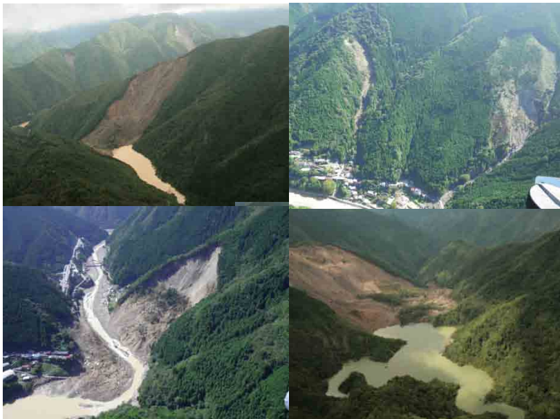
2011年台風12号では、1回の雨で約1億m 3 の斜面崩壊が発生。
