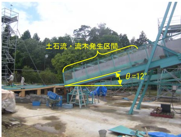
写真1 谷に見立てた水路
