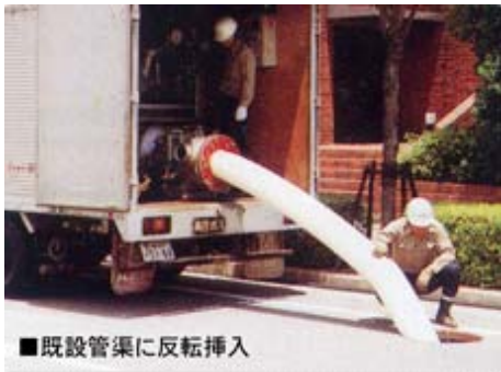
更生工法(現場硬化管)
