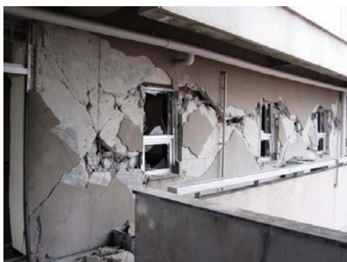
鉄筋コンクリート造建築物の非構造壁の損傷
