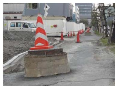
液状化によるマンホールの浮き上り
