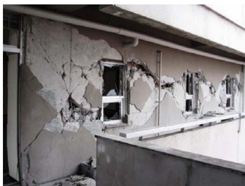
東日本大震災における鉄筋コンクリート造建築物の非構造壁の損傷
