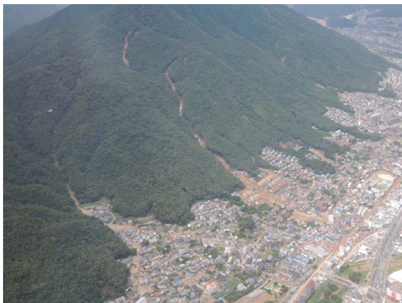
平成 26 年 8 月 広島市で発生した土砂災害
