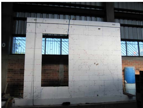
コンクリートブロック造壁の 水平加力実験終了後の様子
