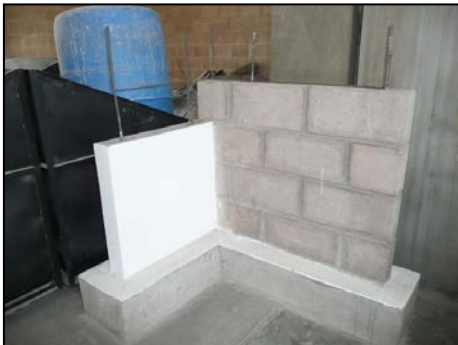
コンクリートブロック造
