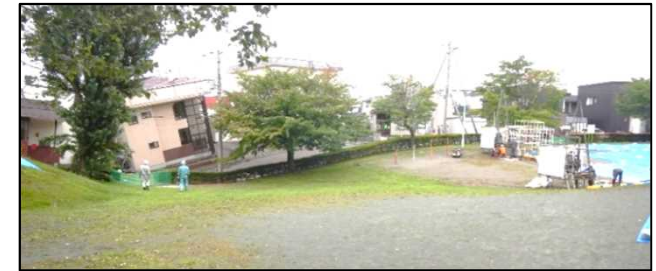
平成30年北海道胆振東部地震における液状化被害 (札幌市清田区)
