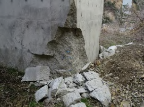
橋脚基部の損傷
