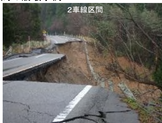
4車線／2車線区間の崩壊事例
