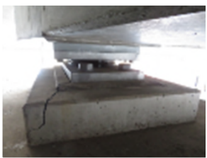
橋脚基部の損傷
