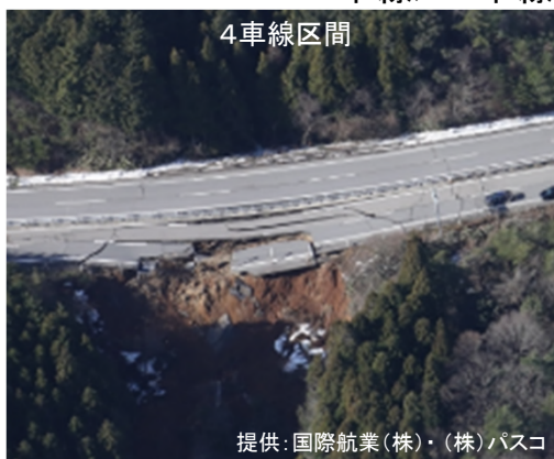
4車線／2車線区間の崩壊事例
