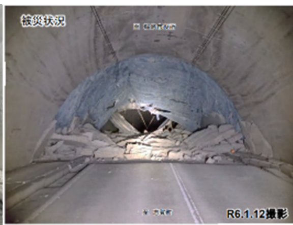
中屋トンネル(国道249号)
