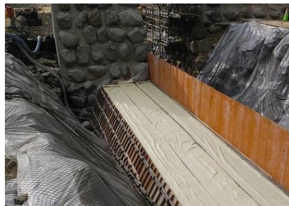
仮締切工(砂防コンクリート締切)
