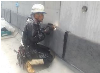
排水材設置工
