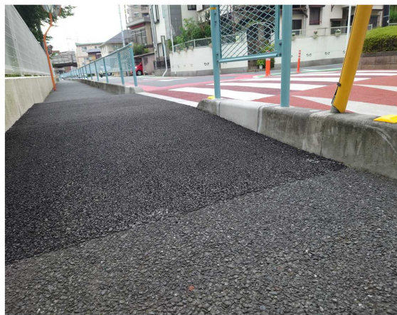
歩道部を嵩上げ
