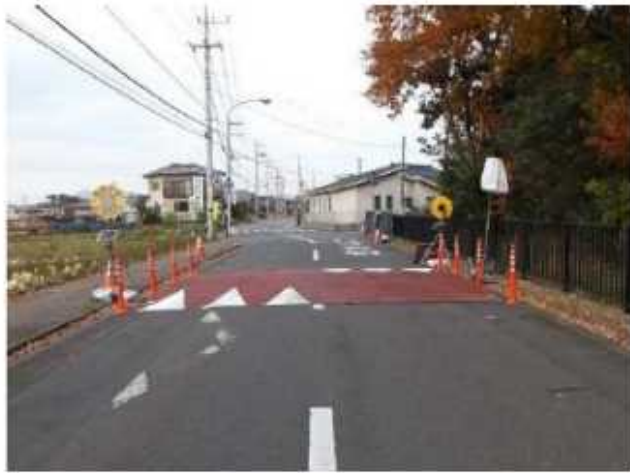
図 3-8. 設置した高さ 10cm の凸部 (つくば市)
