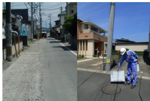
未耐震路線(左)と耐震化路線(右)で被害程度に大きな差
