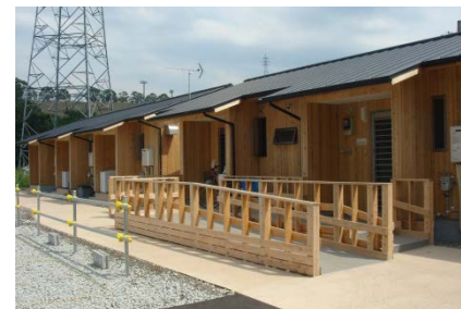
写真4 木造の応急仮設住宅の恒久住宅への活用の検討
