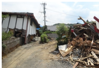
写真2 住宅地の被災状況 御船町
