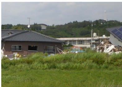
写真1 住宅地の被災状況 南阿蘇村
