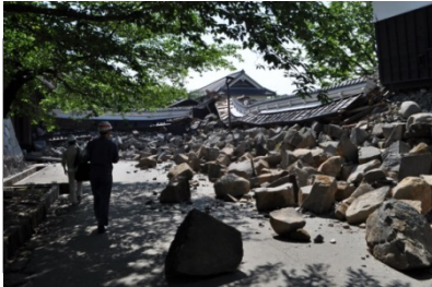
石垣の大規模な崩落 (熊本城公園)
