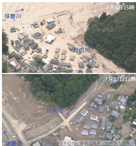
写真-5 川内川での土砂・洪水氾濫の発生状況
