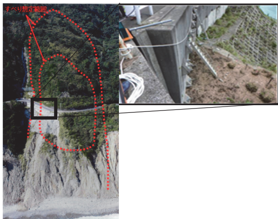
写真-8 国道448号 (宮崎県提供) (左: 斜面全景、右: アンカーの破断状況)
