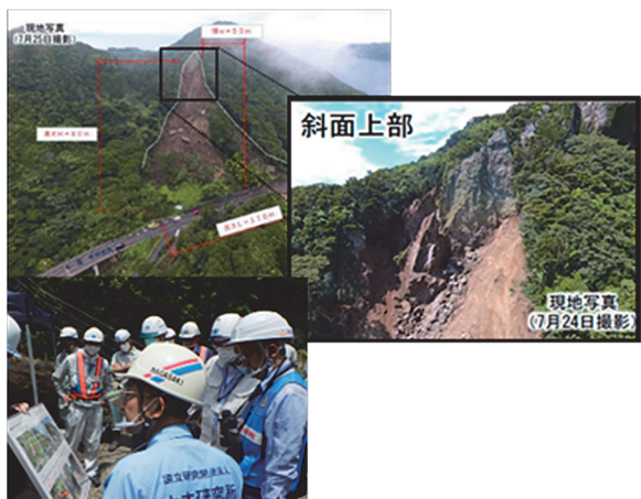
写真-9 主要地方道平戸生月線 (長崎県提供)
