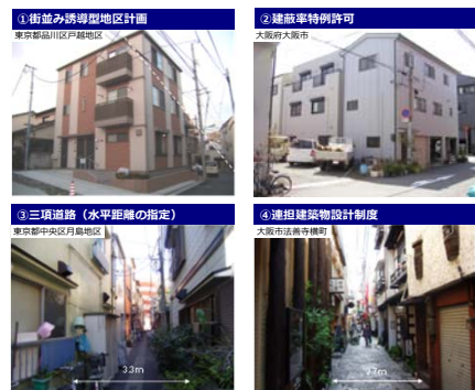
図7 まちづくり誘導手法を活用した建替え成功事例
