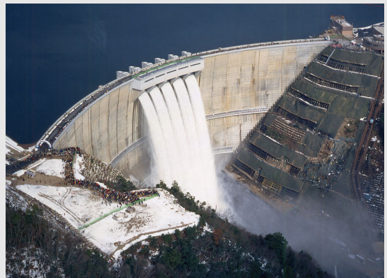
写真－1 温井ダム（中国地方整備局）
