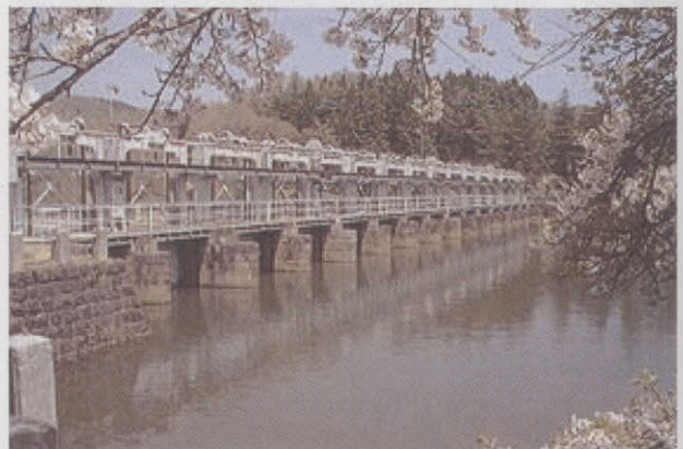
写真-3 十六橋水門
